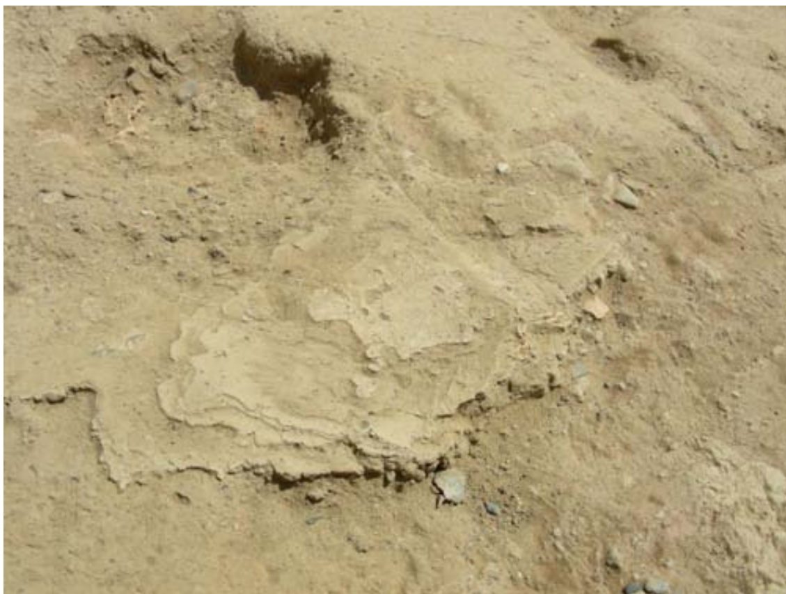
Figura 216: Detalle de los restos dejados por el ingreso de agua a la cámara.
