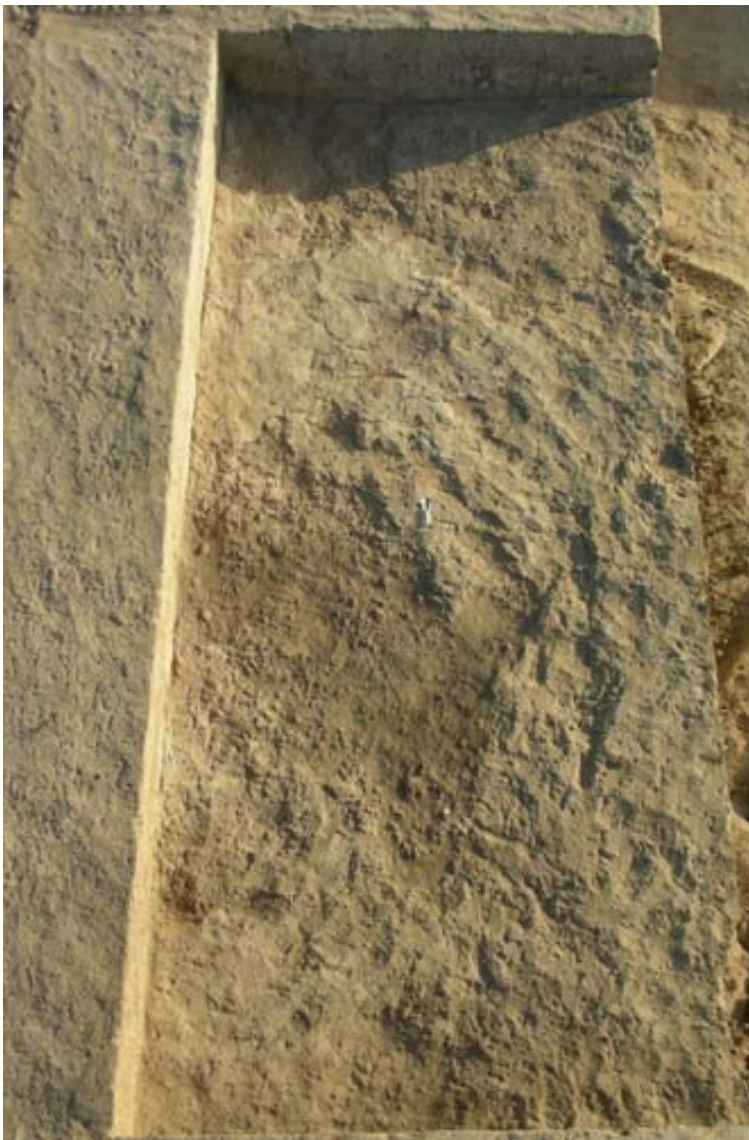
Figura 172: Fotografía de la Capa 2 de la extensión sur-oeste.
