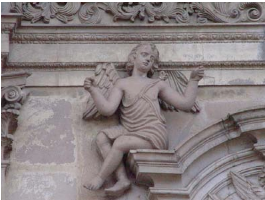
Detalle de la fachada de la Iglesia de San Francisco, Quito.
