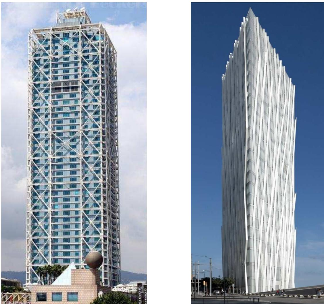
Figura 3.2-1. Ejemplos de edificios en altura con malla estructural envolvente: Hotel Arts y Torre Diagonal ZeroZero de Barcelona. (Imágenes propias, 2013).
