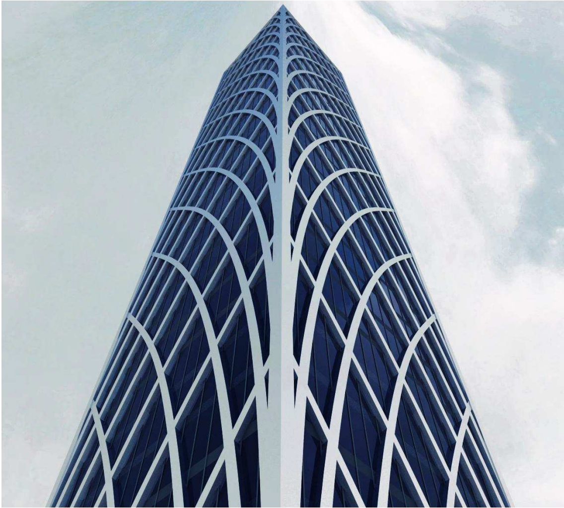
Figura 5.6-28. Vista de la propuesta de estructura envolvente de acuerdo a geometría optimizada según a los resultados del estudio comparativo final. (Imagen propia).
