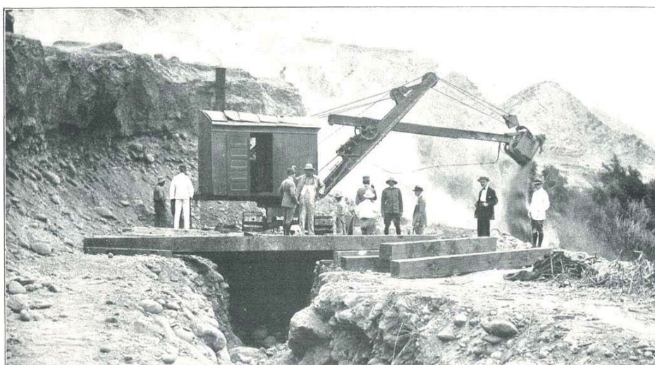
Figura 55 El ministro de Fomento el Dr. Rada y Gamio, Inspeccionando los trabajos en las pampas del Imperial, Cañete, Perú.
