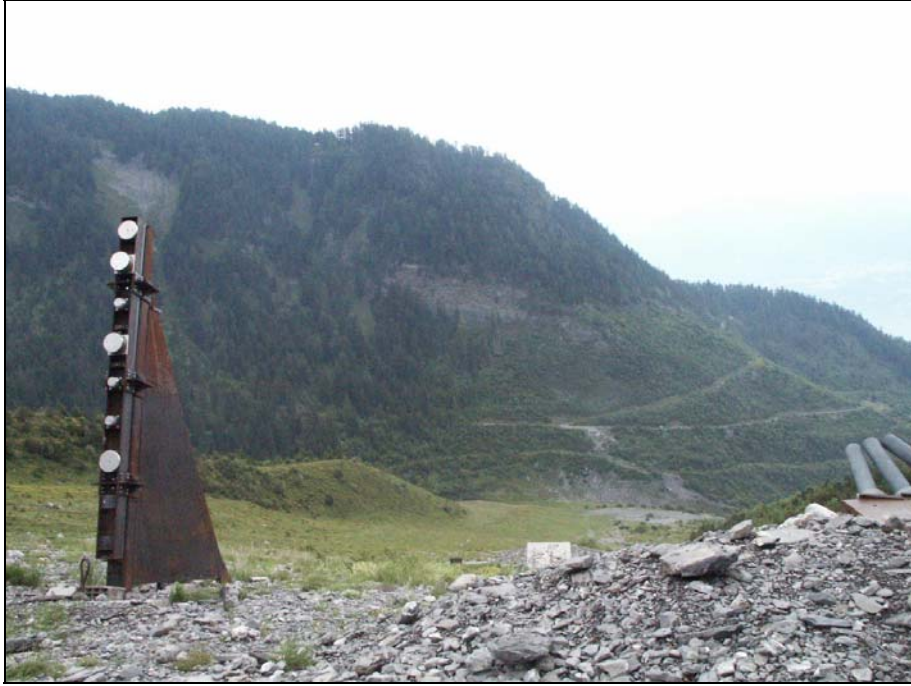
Figura 4-13. Sensores de presión, velocidad y densidad a diferentes alturas del flujo instalados a lo largo del canal de aludes. Fotografía realizada por Glòria Furdada Bellavista.
