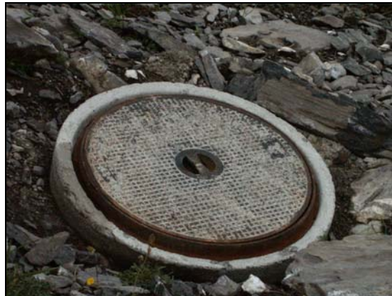
Figura 4-10. Radar FMCW instalado en el suelo. Fotografía realizada por Glòria Furdada Bellavista
