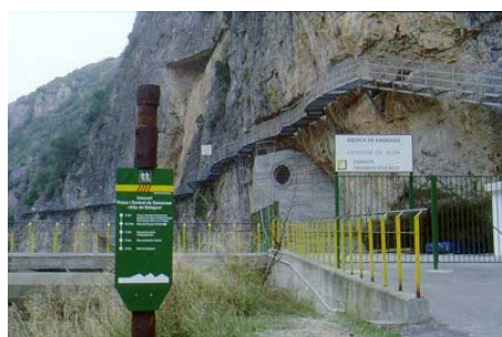
Fig. 3.7. Passarel·la metàl·lica a la Presa de Camarasa
