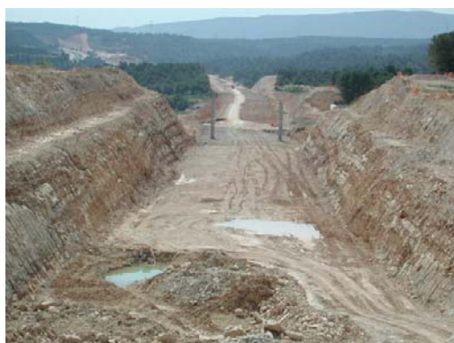
Fig. 3.12. Obres de l'AVE al seu pas per Tarrés
