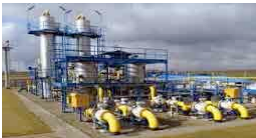
Imagen 3. Instalaciones de gas en Argelia. Fuente: webislam.com
