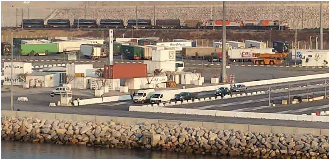
Imagen 10. Instalaciones portuarias Ro-Ro en Tanger-Med II. Elaboración propia.
