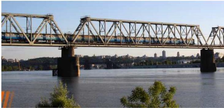
*Figura 3: Ejemplo de celosía típica: un puente de ferrocarril*
