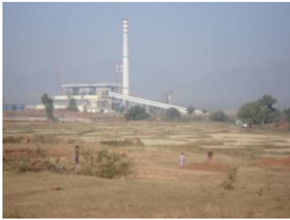
The Vedanta Refinery
