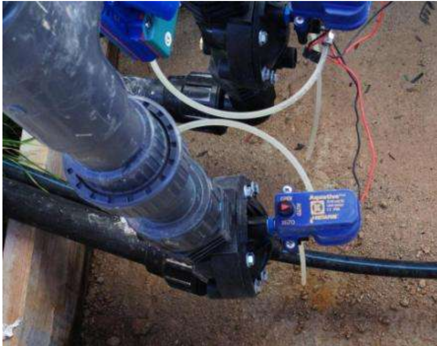
Figura 165. Instal·lació del sistema de control de reg
