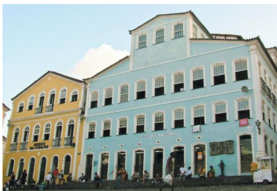
Figura 3.61: Edificio de la Fundación Casa de Jorge Amado.
