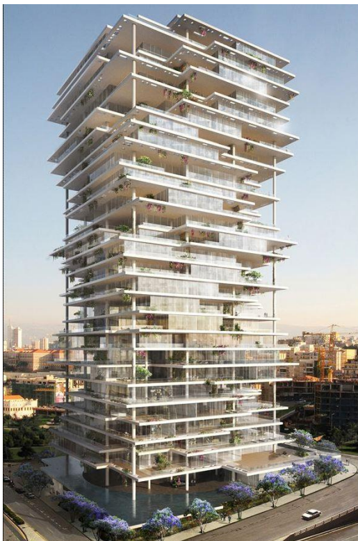
Figura 3.9: Edificio Beirut Terraces, de Herzog & de Meuron
