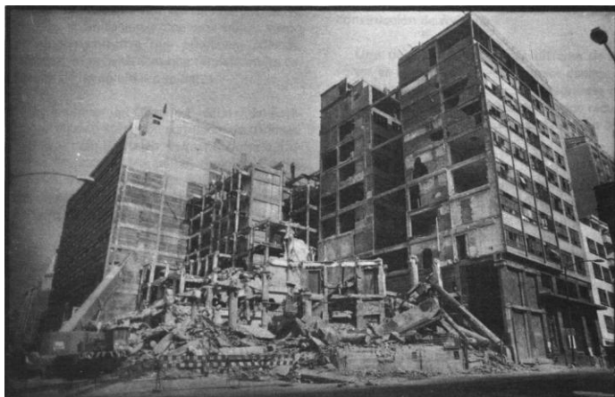
Figura 3.38: Edificios del área central dañados por el sismo de 1985.
