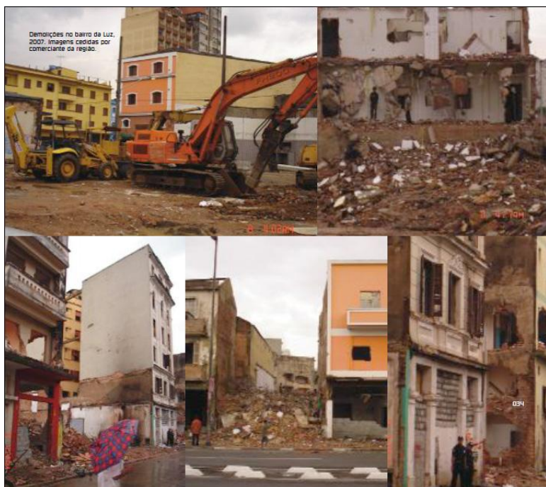
Figura 3.67: Inicio de las demoliciones.
