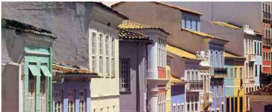
Figura 3.65: Fachada de los inmuebles después de La conclusión de las primeras etapas de intervención.
