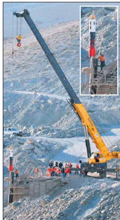
Con una grúa similar a ésta, la capsula será introducida al ducto de 66 cm de diámetro forrado con tubos de metal (en la foto) por donde saldrán los mineros.
