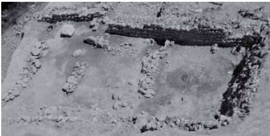
Imagen 7.5.: Vista de la planta de Habitación H3 con la delimitación de sus estancias mediante los tabiques medianeros.
