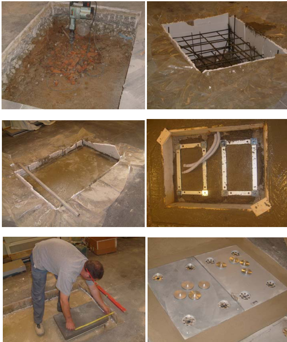
Figura 13-. Procés per soterrar les plataformes.
