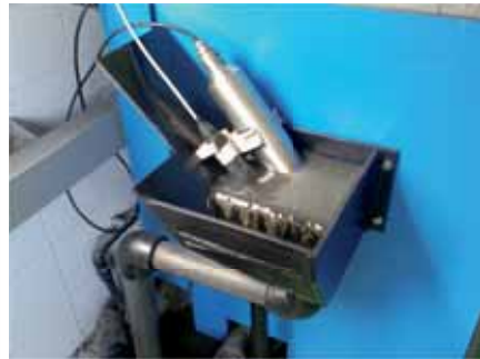
Figura 5.2. a) Esquema d'un sensor electroquímic d'oxigen estàndard per operar en una estació depuradora. b) Instal·lació habitual del sensor d'oxigen a la sortida d'un tanc de fangs activats.
