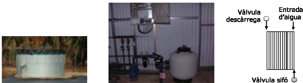
Figura 5.2 Fotografia del dipòsit de 13.000 litres , tapat amb una tela permeable negra on s'emmagatzema l'aigua regenerada (esquerra). Fotografia del programador de reg, el filtre de sorra i les electrovàlvules (centre). Figura del circuit tancat de tubs porta degoters amb emissors cada 30cm (dreta, adaptat de Biel et al. 2006 ).
