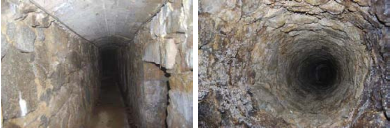
Figura 6.12. A l'esquerra, galeria de l'interior de la presa del pantà Gros. A la dreta, un dels pous de control des de la galeria i amb la càmera cap enlaire.
