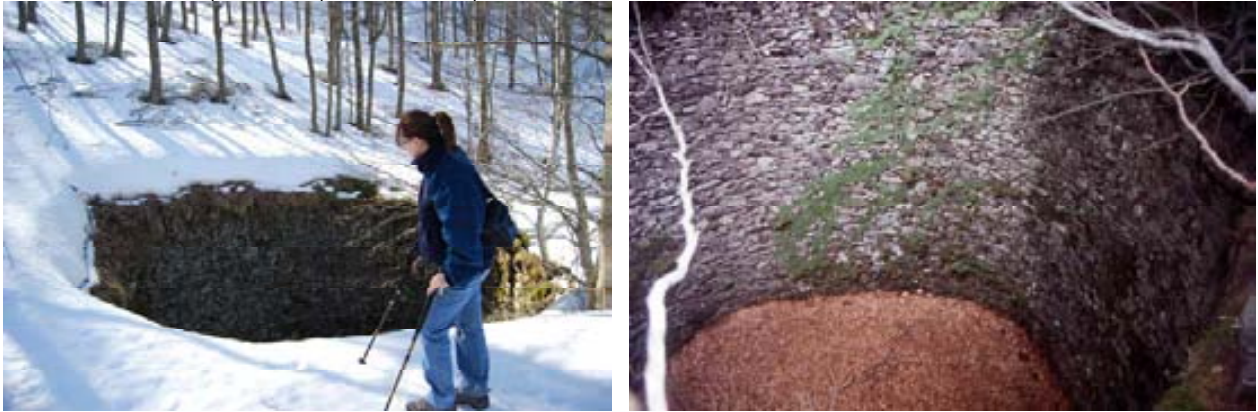
Figura 6.4. Estat actual del Pou del Comte, a l'esquerra mostrant el seu aspecte hivernal i, a la dreta, la seva fondària i la paret de pedra seca que el revesteix.
