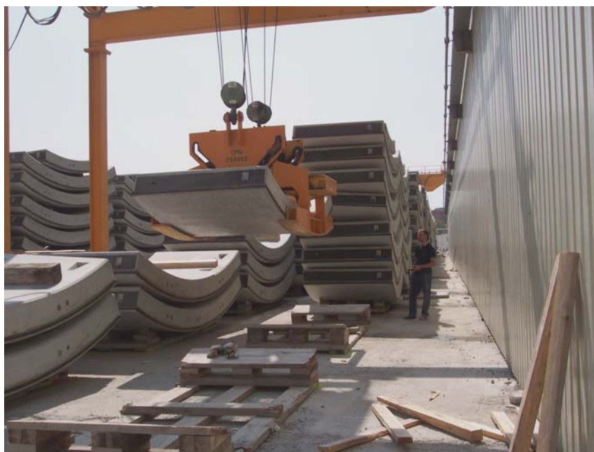
Figura 58.- Fase de de preacopio: manejo de la grúa pórtico.
