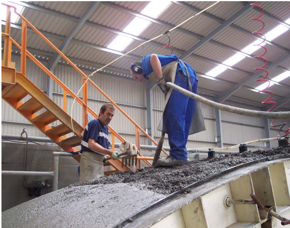
Figuras 40.- Fase de fratasado, alisado y limpieza: alisado y uso del vibrador.
