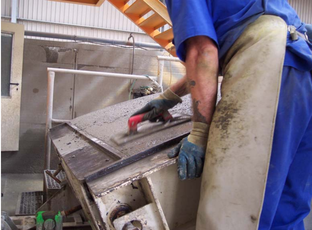
Figuras 39.- Fase de fratasado, alisado y limpieza: alisado y uso del vibrador.
