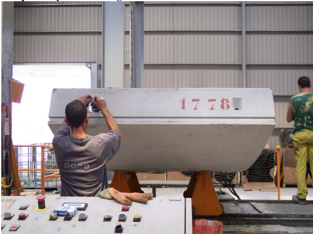
Figuras 48.- Fase de pintado y de colocación de juntas de estanqueidad y gomas: pintado y encolado de gomas.
