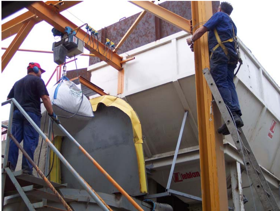
Figuras 63.- Trabajos de mantenimiento: reparación de instalación eléctrica.
