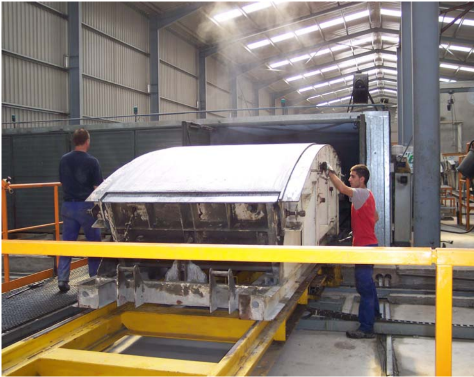
Figuras 9.- Fase de desencofrado: trabajos en el transbordador
