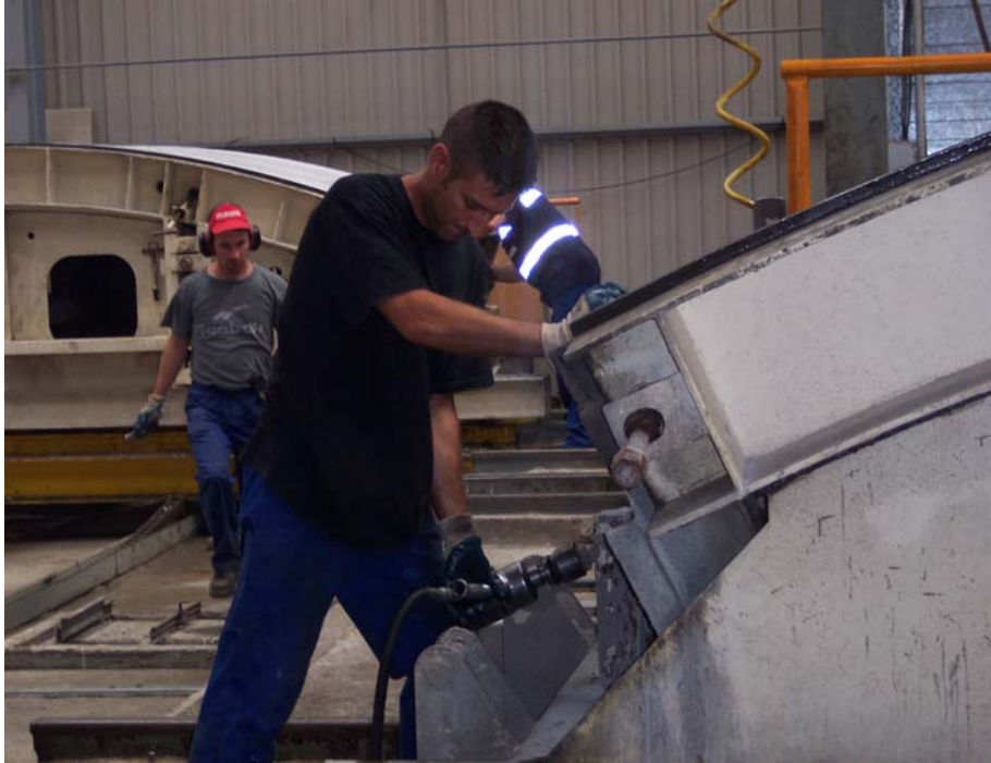
Figuras 13.- Fase de desencofrado: trabajos de apertura del molde
