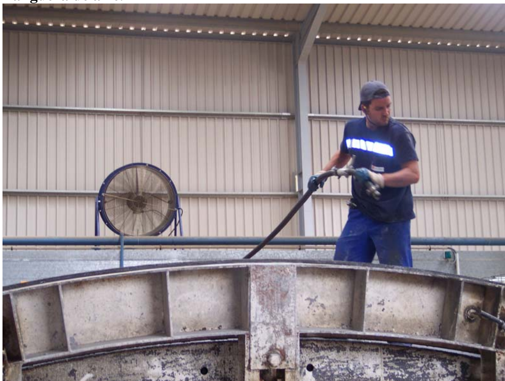
Figuras 17.- Fase de limpieza del molde: colocación tubo de inyección y uso de la manguera de aire.
