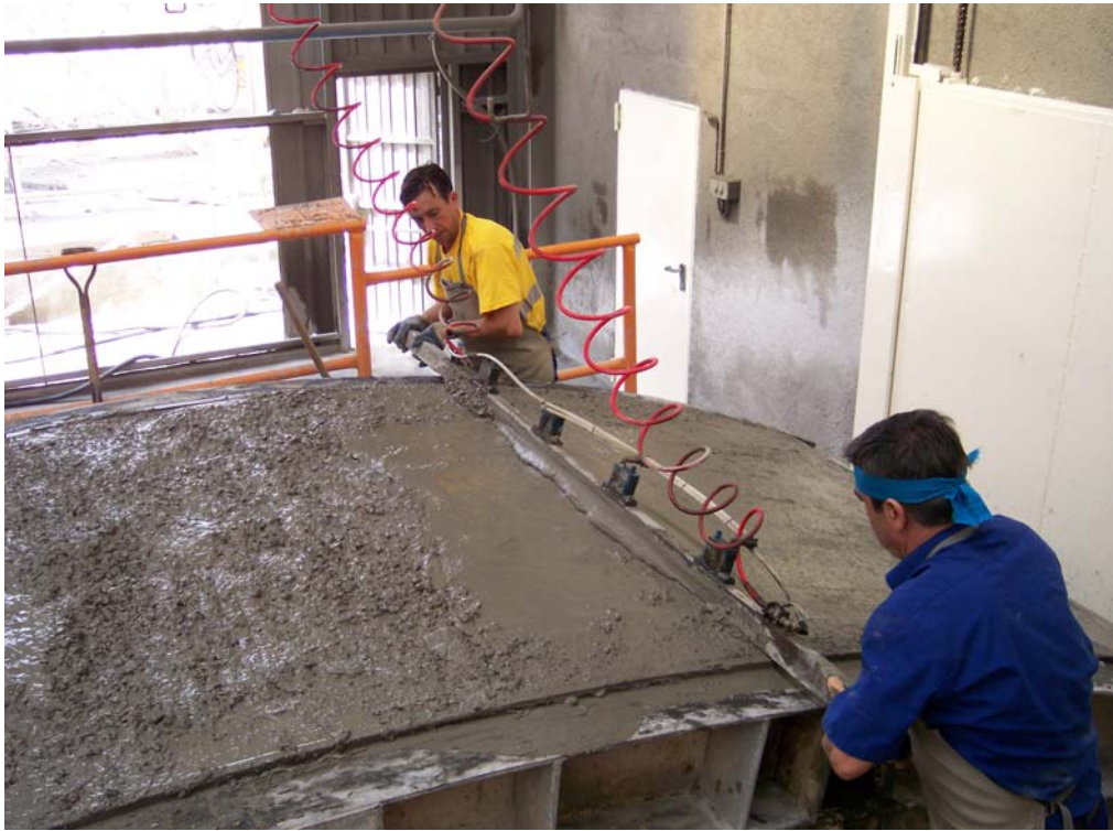
Figuras 31.- Fase de fratasado, alisado y limpieza: uso de la regla-vibrador.
