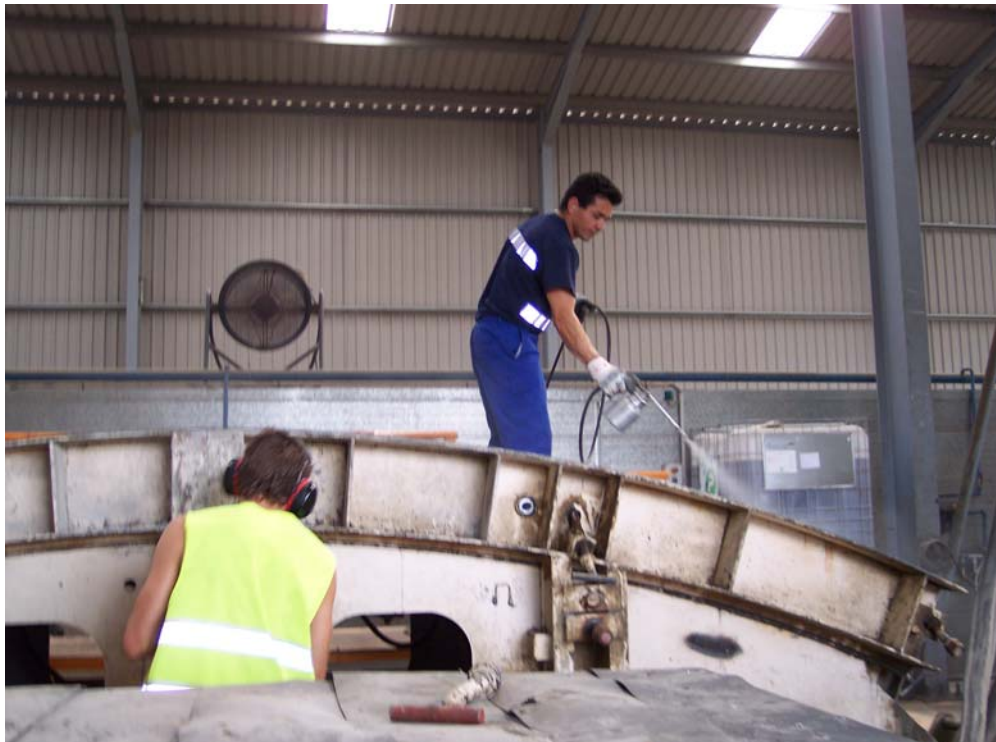
Figuras 18.- Fase de limpieza del molde: proyección del desencofrante y cierre del mismo simultáneamente.
