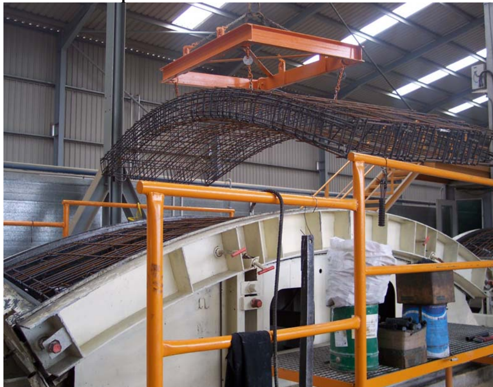
Figuras 24.- Fase colocación de la armadura: transporta de la armadura de la noria a la cadena de producción.
