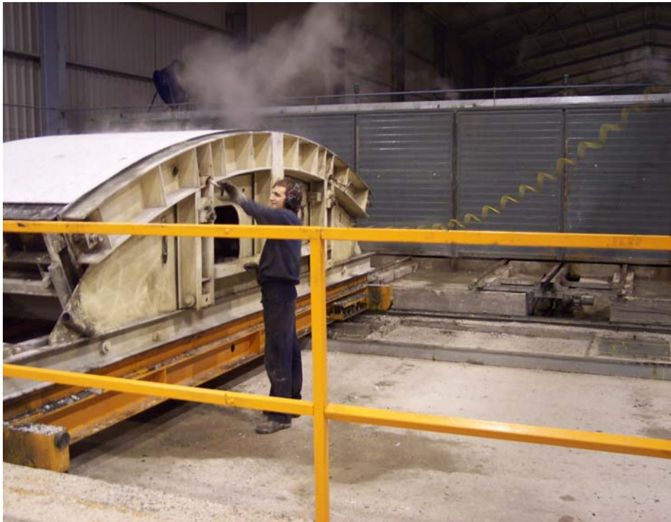
Figuras 11.- Fase de desencofrado: trabajos en el transbordador
