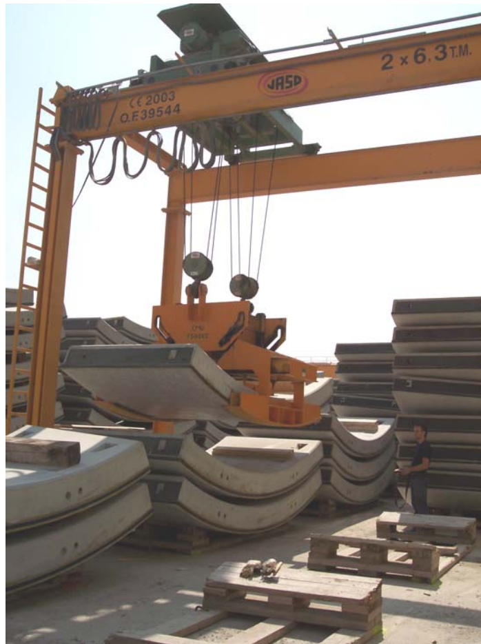
Figura 57- Fase de de preacopio: manejo de la grúa pórtico.
