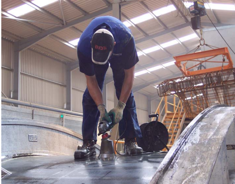
Figuras 20.- Fase de limpieza del molde: tareas auxiliares de limpieza del molde
