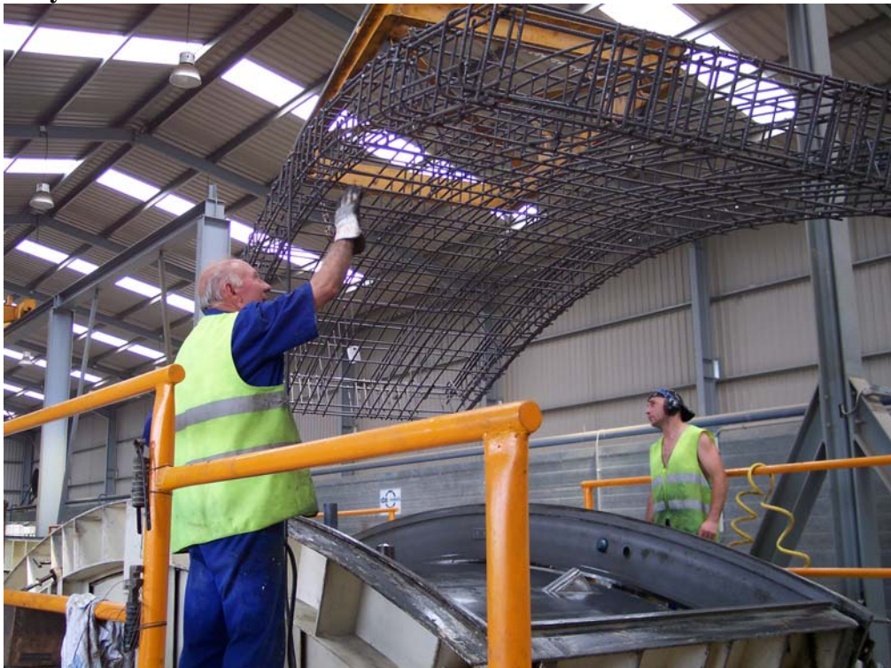
Figuras 25.- Fase colocación de la armadura: colocación de la armadura en el molde y cierre del molde.
