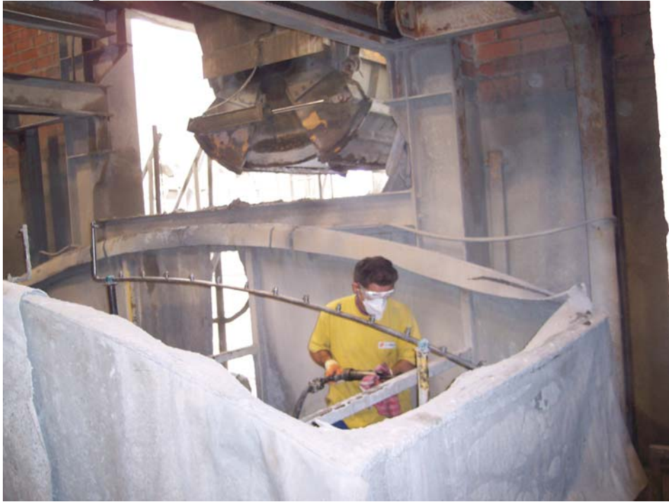
Figuras 86.-Rutina de trabajo del sábado: limpieza de la cabina de hormigonado en la zona de recepción de los moldes.
