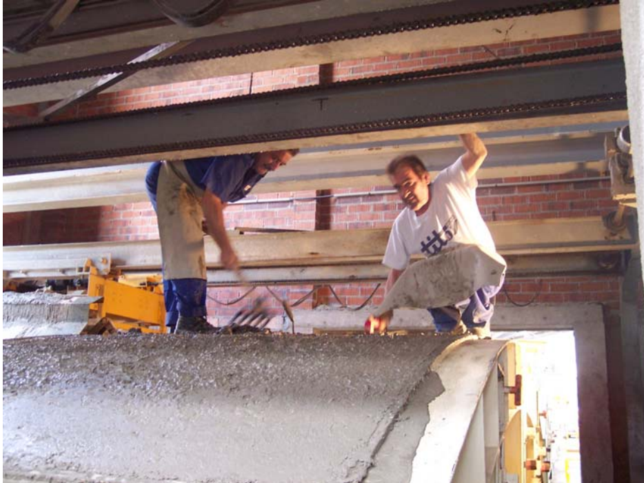
Figuras 41.- Fase de fratasado, alisado y limpieza: fratasado y alisado.
