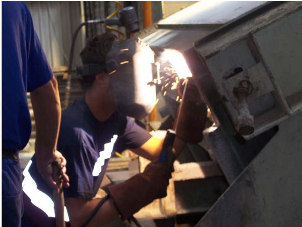
Figuras 70.- Trabajos de mantenimiento: soldadura eléctrica al arco.
