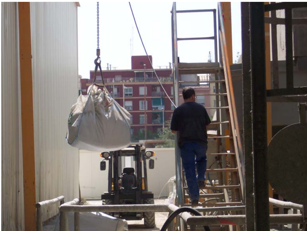
Figuras 64.- Trabajos auxiliares: suministro de materiales de la planta.
