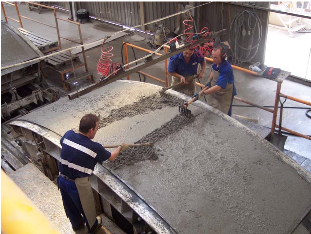
Figuras 34.- Fase de fratasado, alisado y limpieza: fratasado y alisado con palas.
