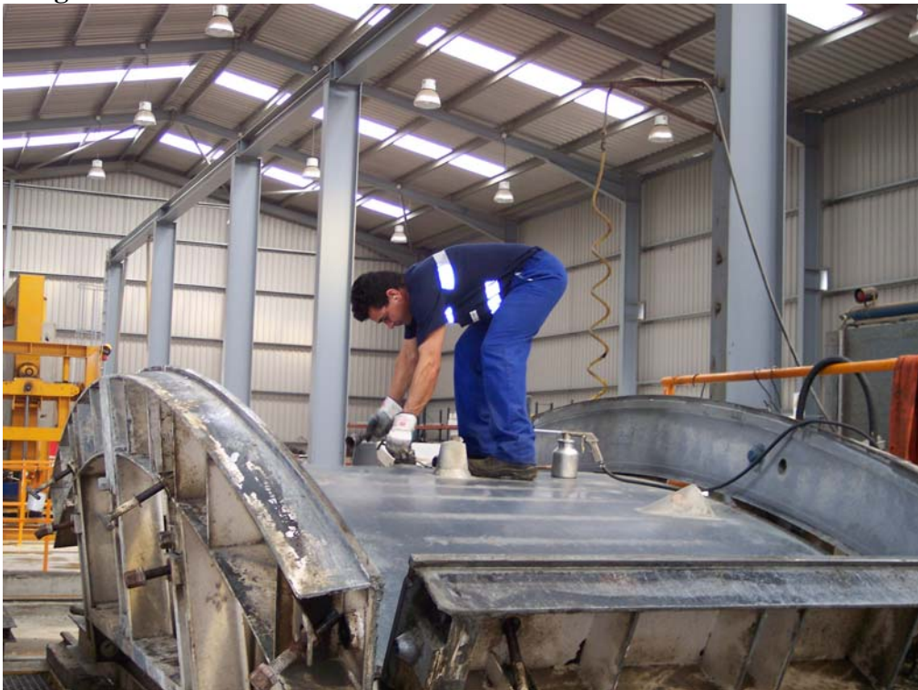
Figuras 16.- Fase de limpieza del molde: colocación tubo de inyección y uso de la manguera de aire.
