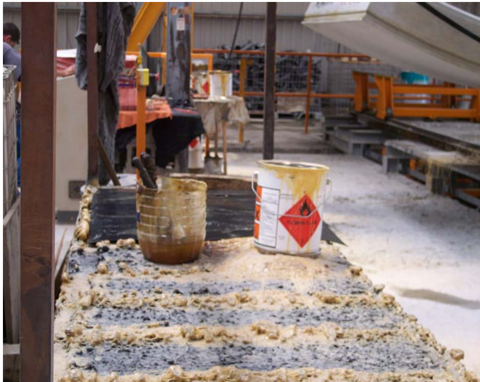
Figuras 53.- Fase de pintado y colocación de juntas de estanqueidad y gomas: zona de encolado.
