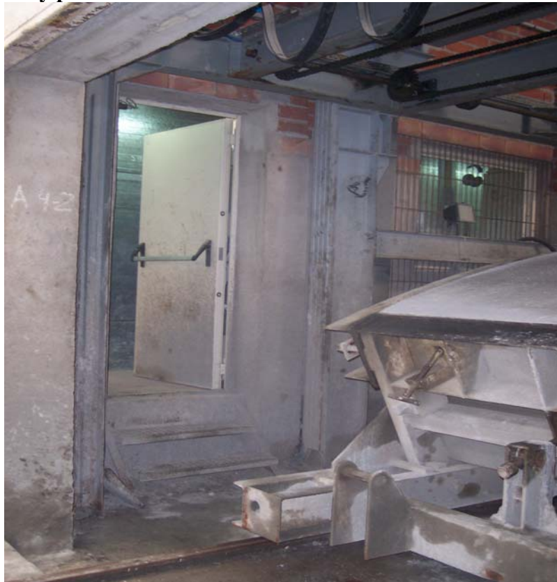
Figuras 29.- Fase de hormigonado y vibrado: acceso a la zona de vibrado del molde-cabina y panel de control.
