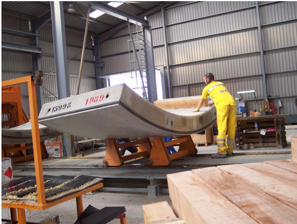
Figura 56- Fase de pintado y de colocación de juntas de estanqueidad y gomas: colocación de tablonces de madera.
