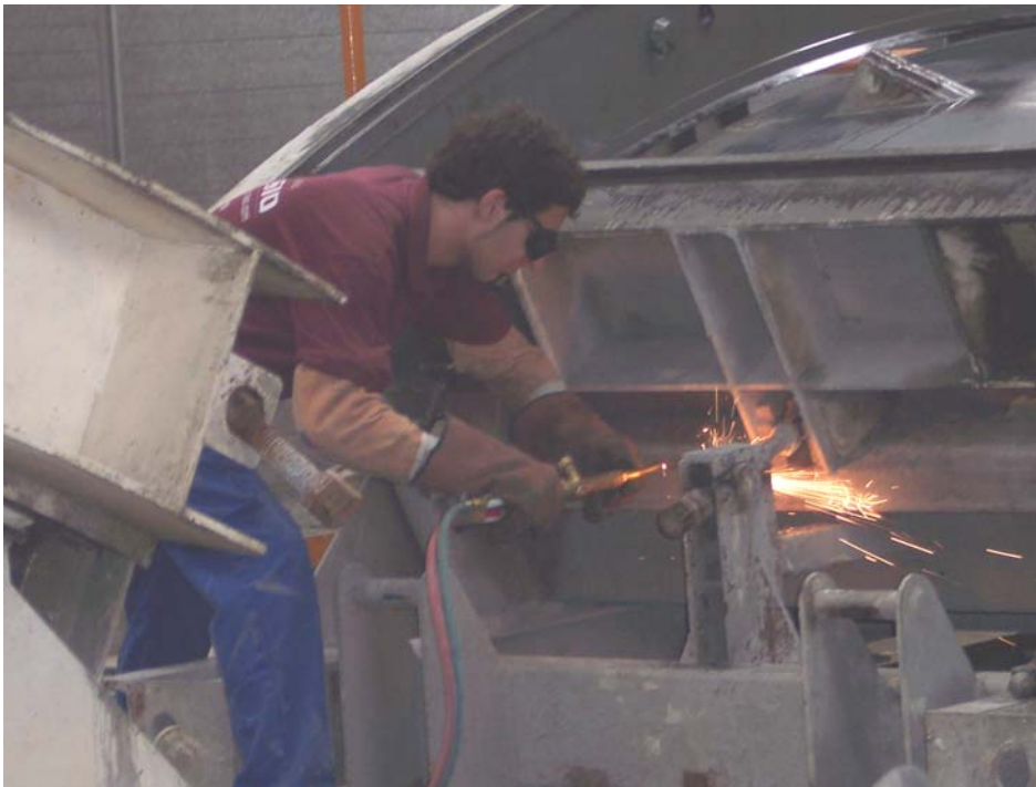
Figuras 72.- Trabajos de mantenimiento: oxicorte.
