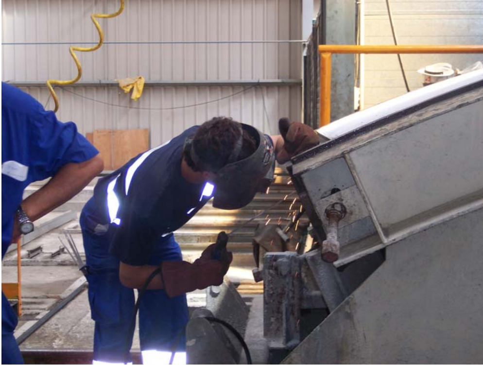
Figuras 71.- Trabajos de mantenimiento: soldadura eléctrica al arco.
