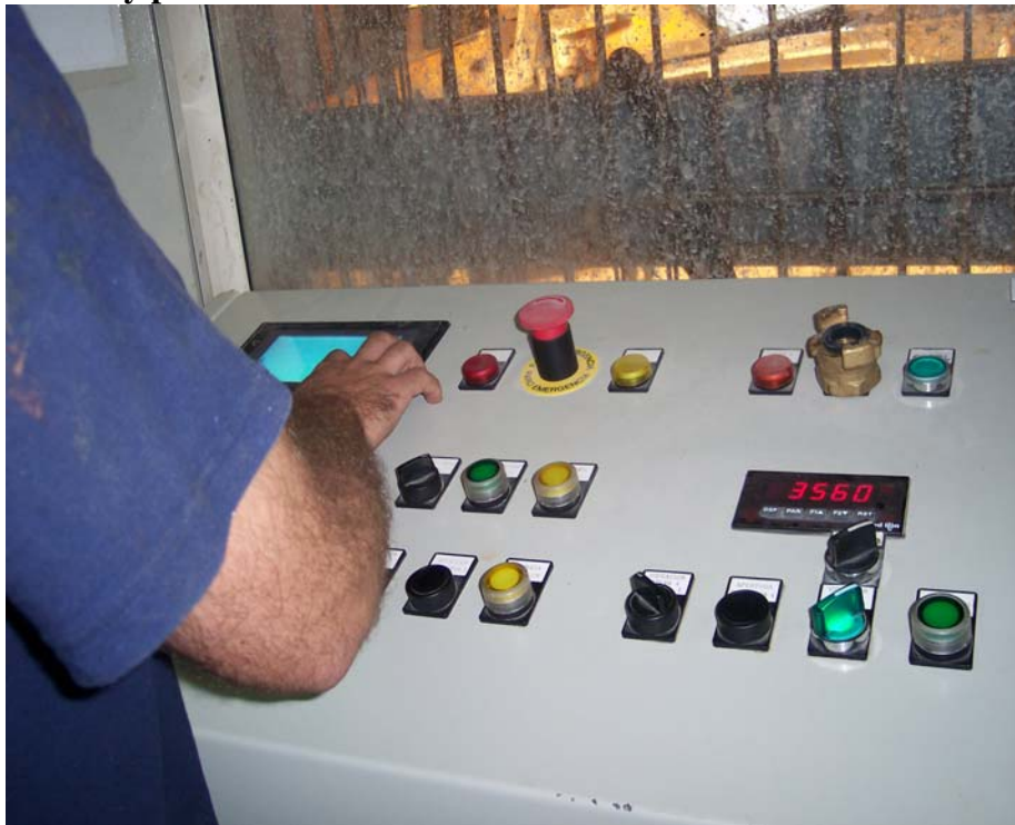
Figuras 30.- Fase de hormigonado y vibrado: acceso a la zona de vibrado del molde-cabina y panel de control.
