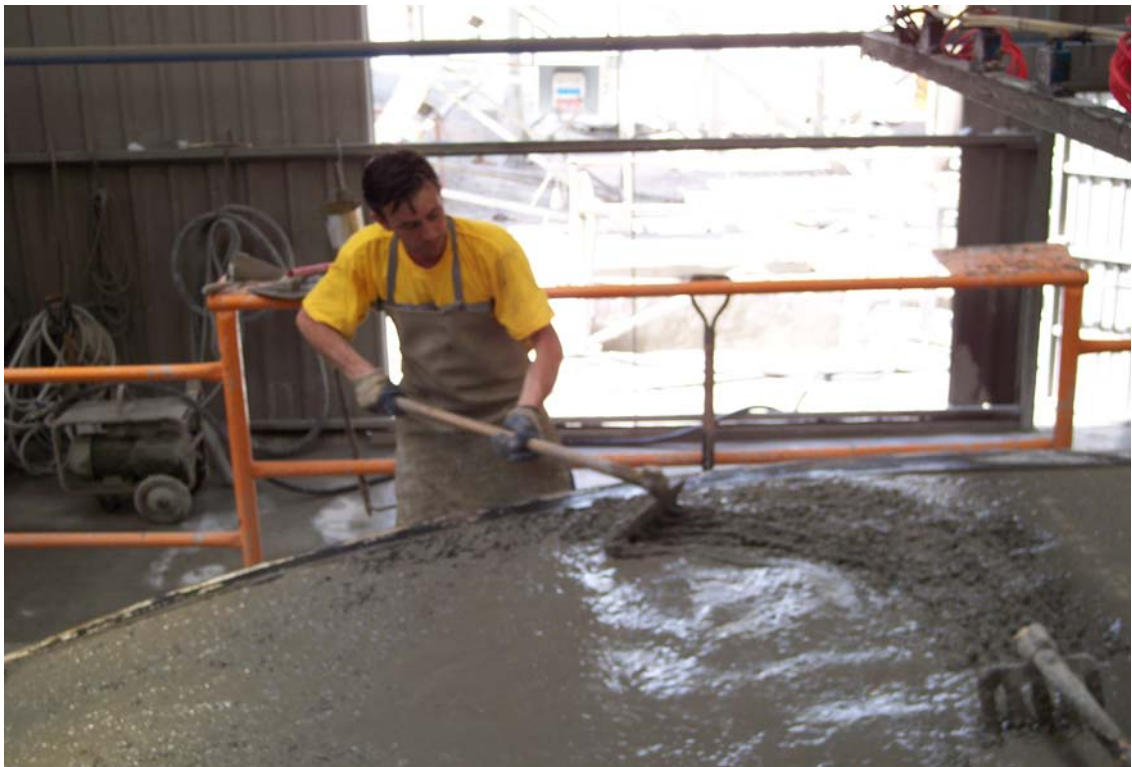
Figuras 36.- Fase de fratasado, alisado y limpieza: fratasado y alisado con rastrillo.
