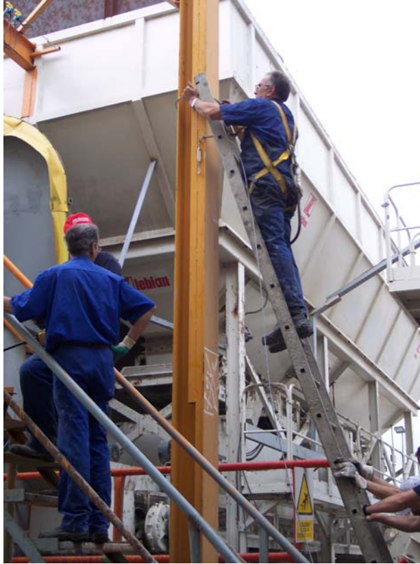
Figuras 61.- Trabajos de mantenimiento: reparación de instalación eléctrica.
