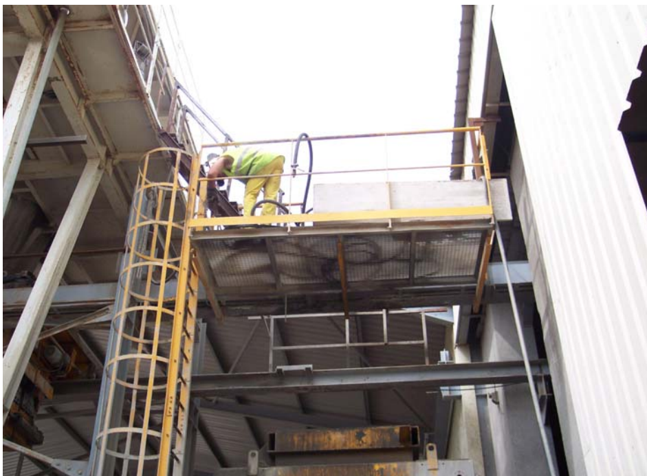
Figuras 83.-Rutina de trabajo de los sábados: limpieza de las tolvas externas de la planta.
