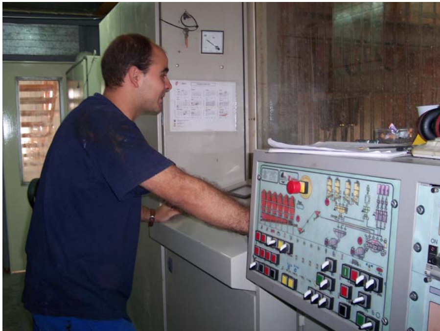
Figuras 27.- Fase de hormigonado y vibrado: puesto de control de la cabina.
