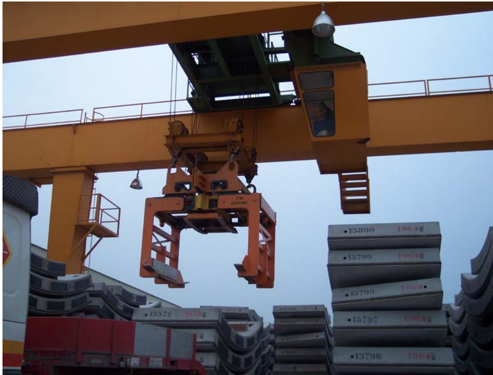
Figuras 60.- Fase de acopio: manejo del puente grúa.
