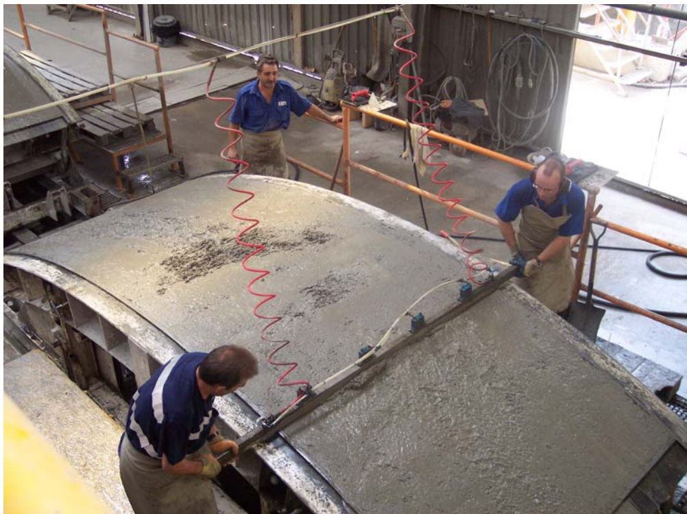
Figuras 32.- Fase de fratasado, alisado y limpieza: uso de la regla-vibrador.
