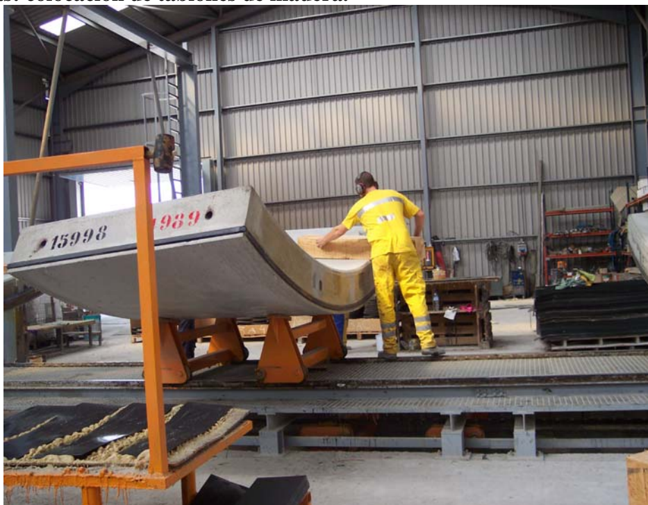
Figuras 55.- Fase de pintado y de colocación de juntas de estanqueidad y gomas: colocación de tablones de madera.
