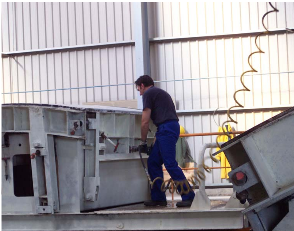
Figuras 12.- Fase de desencofrado: trabajos de apertura del molde
