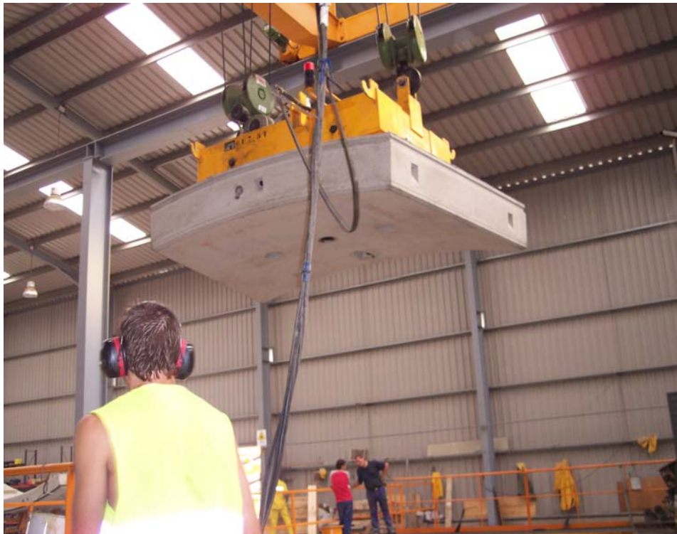
Figuras 44.- Fase de extracción de la dovela: extracción y transporte a la grúa volteadora.
