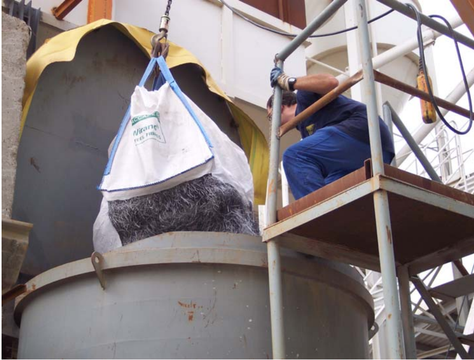
Figuras 69.- Trabajos auxiliares: suministro de materiales de la planta.
