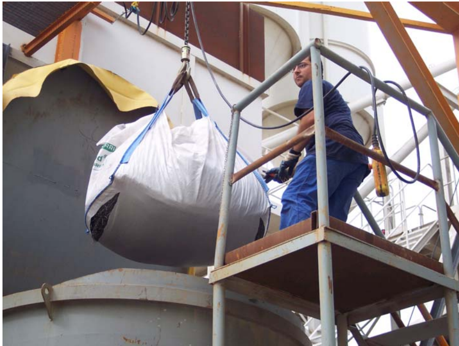
Figuras 68.- Trabajos auxiliares: suministro de materiales de la planta.
