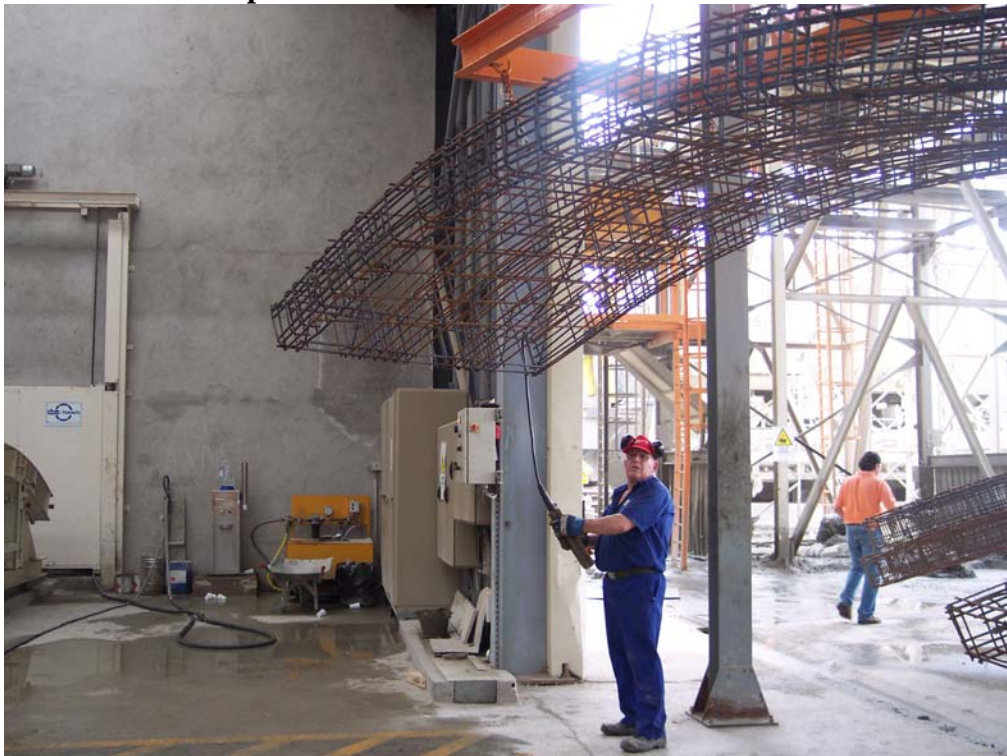
Figuras 23.- Fase colocación de la armadura: transporta de la armadura de la noria a la cadena de producción.
