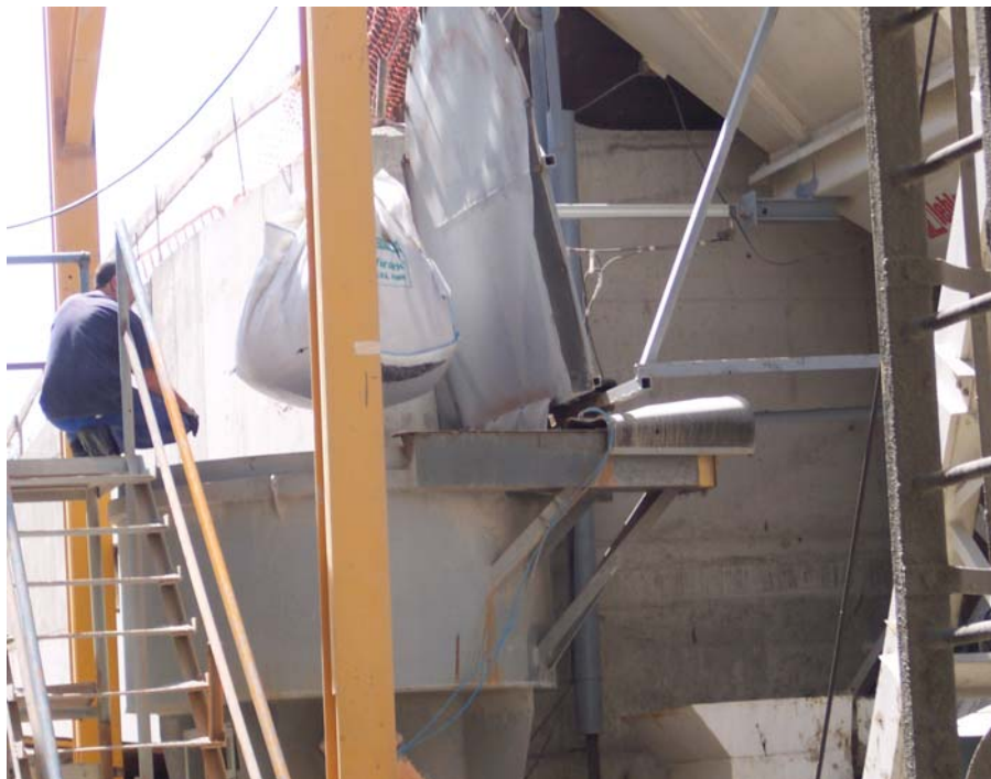
Figuras 66.- Trabajos auxiliares: suministro de materiales de la planta.
