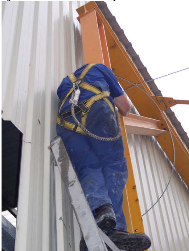
Figuras 62.- Trabajos de mantenimiento: reparación de instalación eléctrica.
