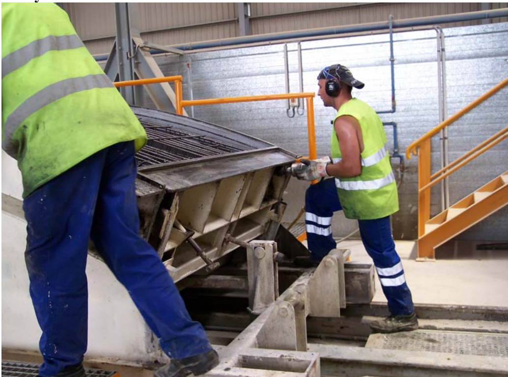
Figuras 26.- Fase colocación de la armadura: colocación de la armadura en el molde y cierre del molde.
