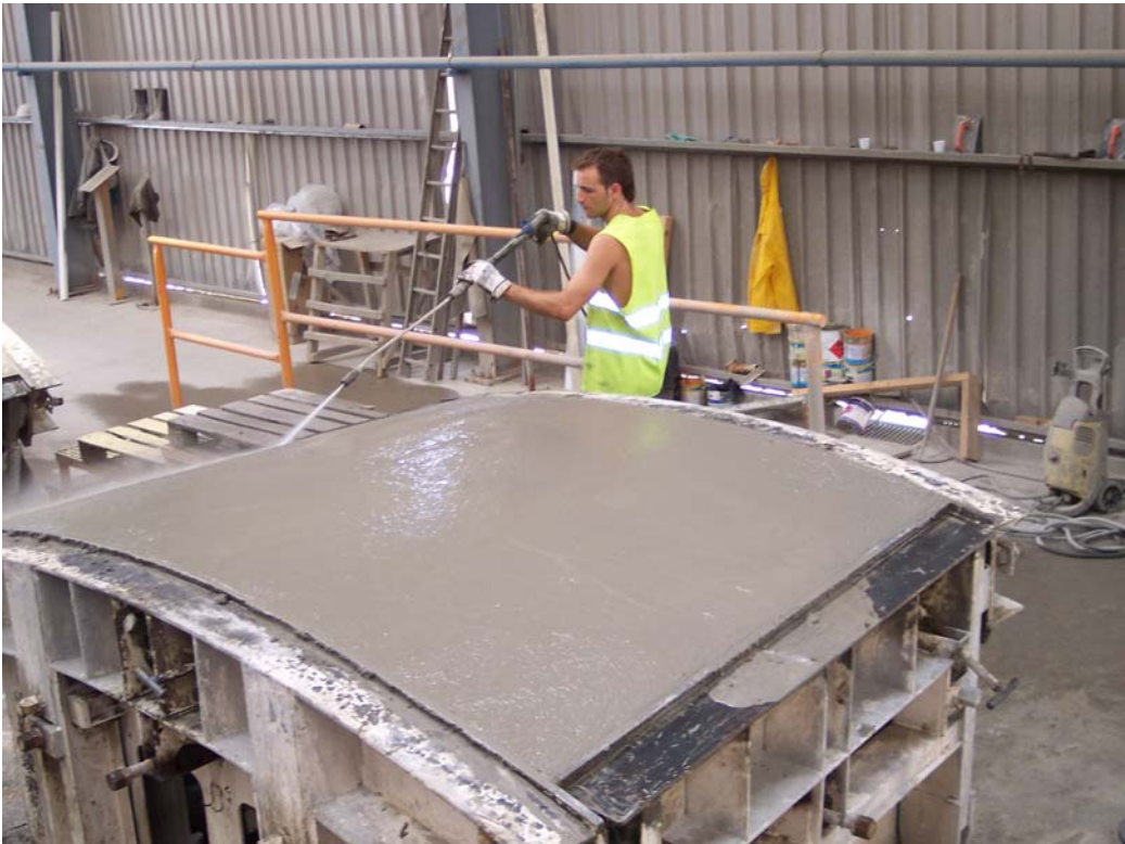
Figuras 37.- Fase de fratasado, alisado y limpieza: limpieza.
