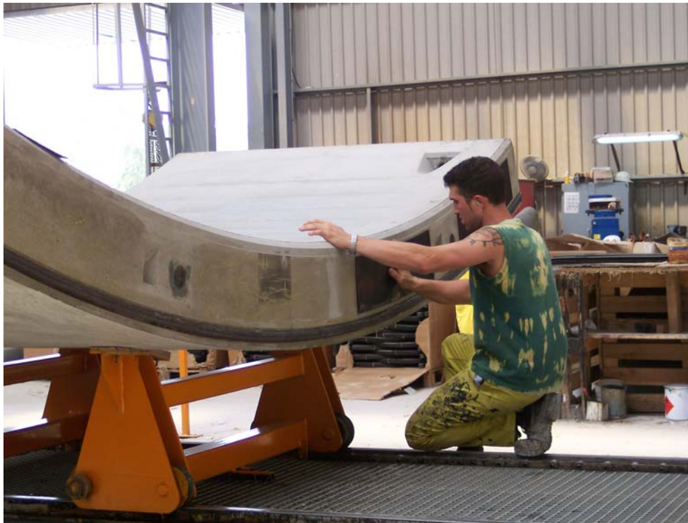
Figuras 52.- Fase de pintado y colocación de juntas de estanqueidad y gomas: zona de encolado.
