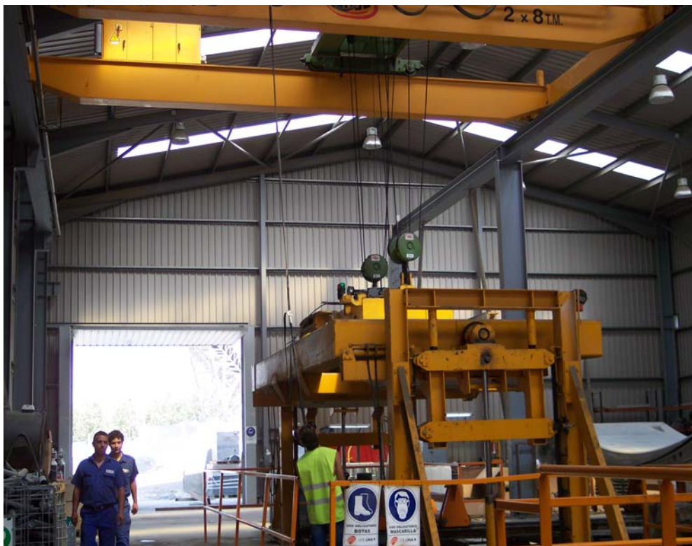
Figura 47- Fase de extracción de la dovela: colocación en la grúa volteadora.
