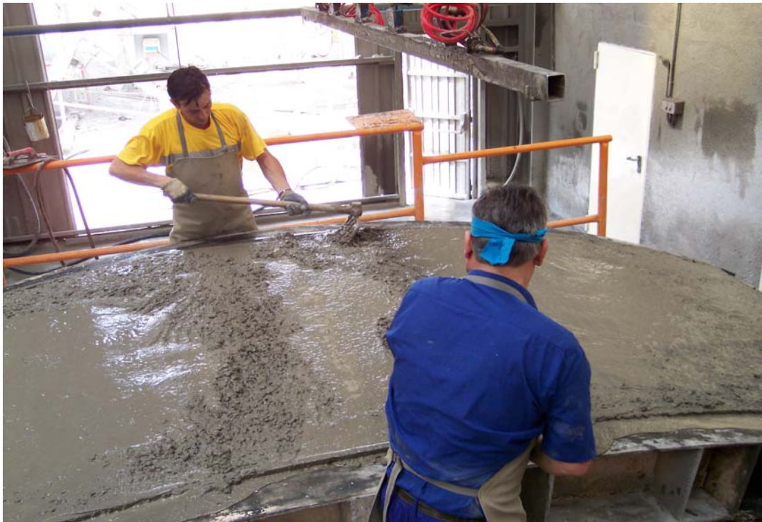
Figuras 35.- Fase de fratasado, alisado y limpieza: fratasado y alisado con rastrillo.
