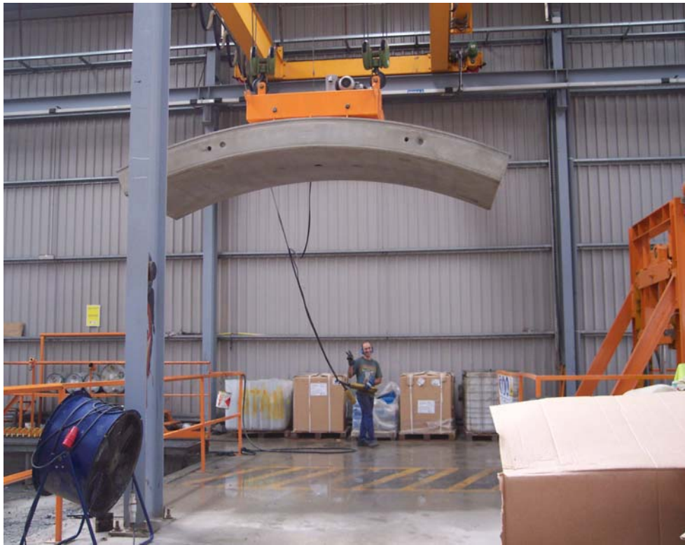
Figuras 46.- Fase de extracción de la dovela: izado y transporte a la grúa volteadora.
