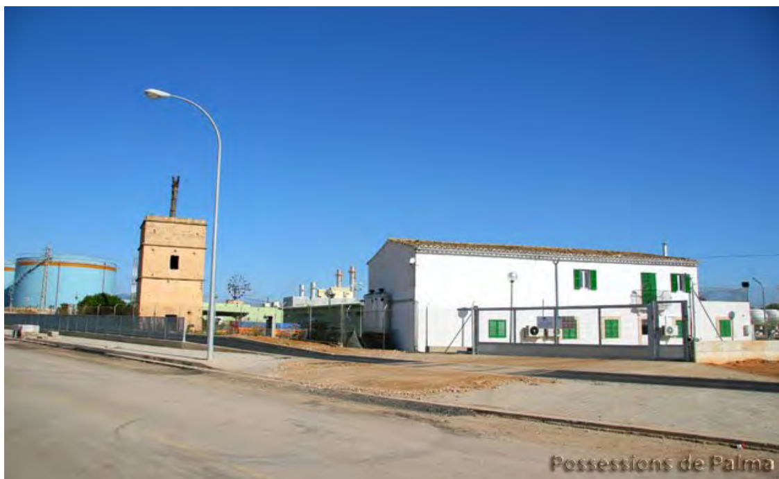
Imagen 4. Restos de “Cal Tresorer”.
