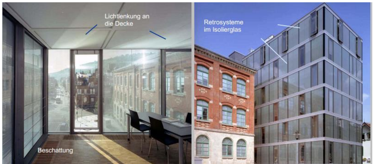
Imagen 3 Espacio de trabajo con luz solar, luz reflejada en el techo, sistema de reflexión integrado en el vidrio y sombreado exterior. Fuente Dr. Ing Helmut Köster, FITLicht; edificio: Landesdenkmalamt Ba-Wü, arquitecto Odilo Reutter, Esslingen
