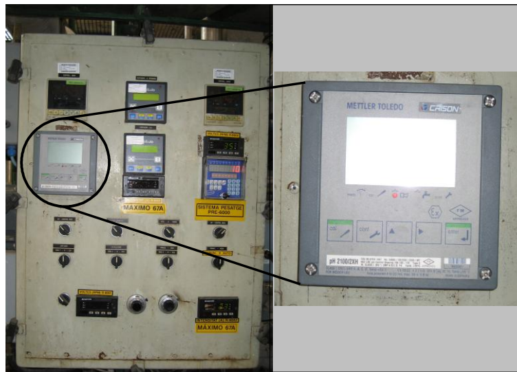
Figura 3.9. Panell de control amb diferents dispositius que controlen tots les paràmetres físics i químics de la reacció.
