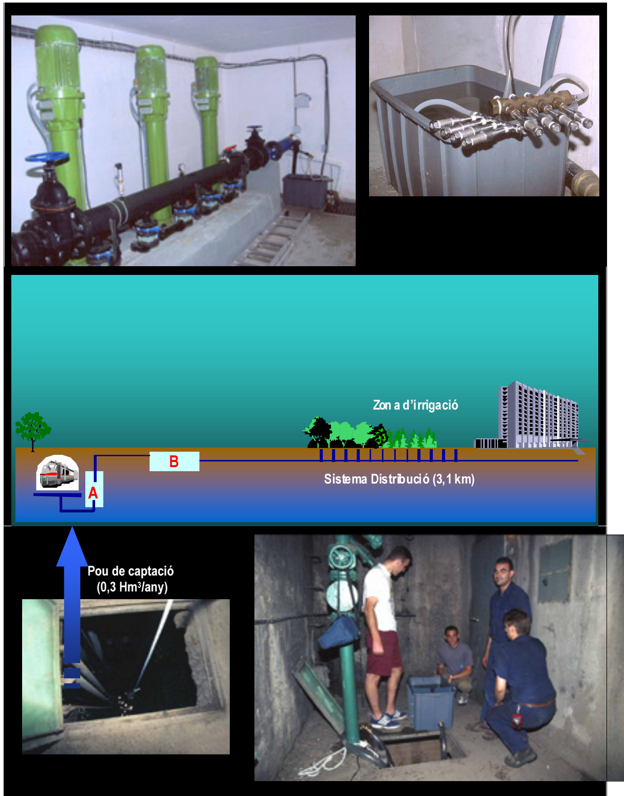
Figura 3.3. Situació dels sistemes experimentals per la monitorització del desenvolupament de biofilms al projecte pilot de reutilització d'aigües freàtiques de Sant Martí, a Barcelona: A) Pou de Captació, imatges a la part inferior, B) Dipòsit de reserva, imatges a la part superior.
