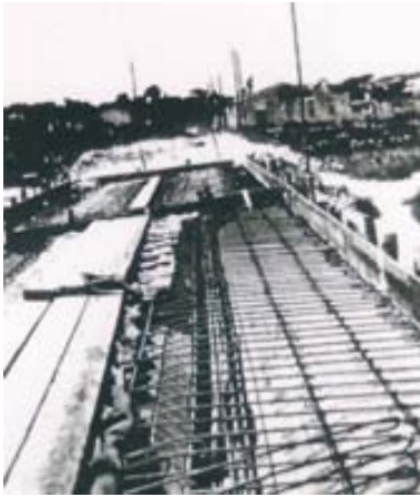
Construcció del Pont del Carrer de santa Anna.
