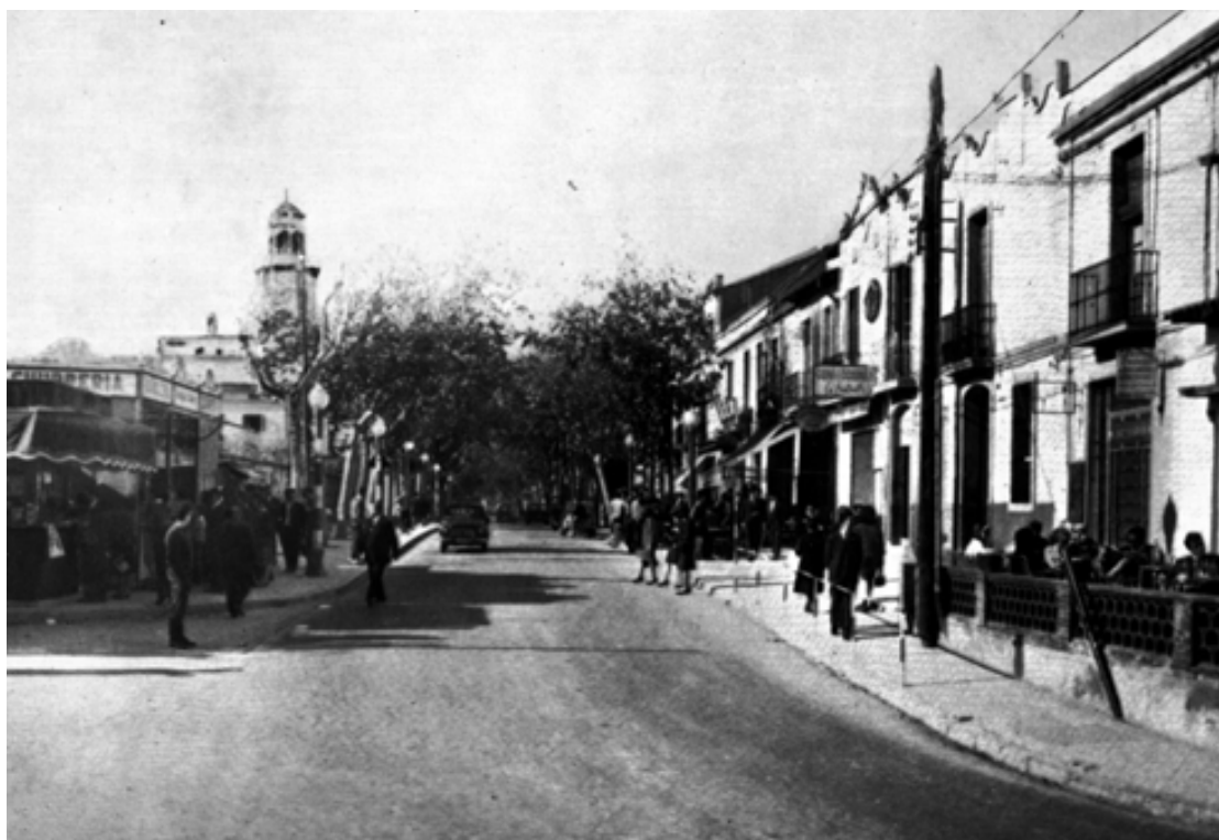
Avinguda de Sant Ignasi, Barri de Baix
