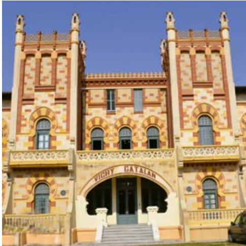
Gaietà Buïgas, façana del balneari de Vichy Català (Caldes de Malavella, 1898)
