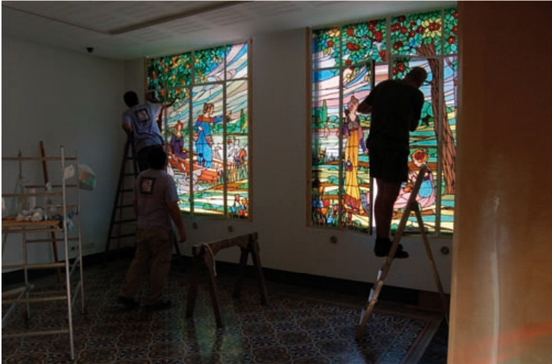
Reinstal·lació dels vitralls
