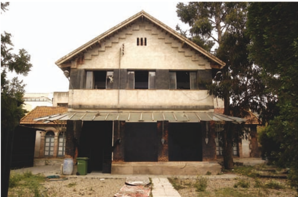
Estat de l'edifici abans de la restauració
