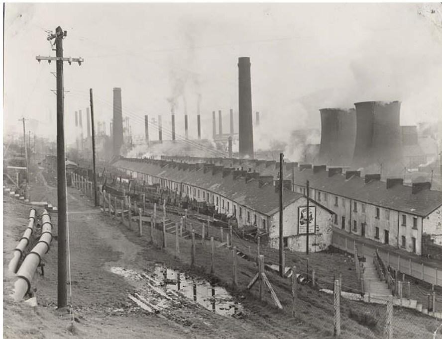
Figura 4.6: Fotografía de viviendas de trabajadores del siglo XIX, EBBW Vale, Gales, demolidas en 1950
