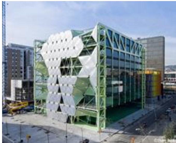
Figura 8.4: Fotografía del edificio Media-TIC, 2015
