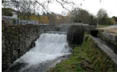
Figure n°44: Centrale hydroélectrique de Sainte Rita
