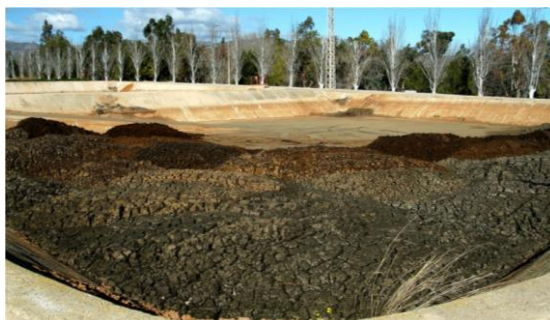
Figura 1.8. Erols d'assecatment dels fangs [75].
