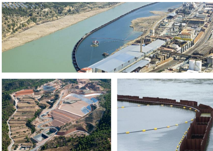
Figura 1.6. Dalt: complex industrial Ercros amb el mur de contenció, Baix esquerra: Racó de la Pubilla, Baix dreta: mur de contenció [68].
