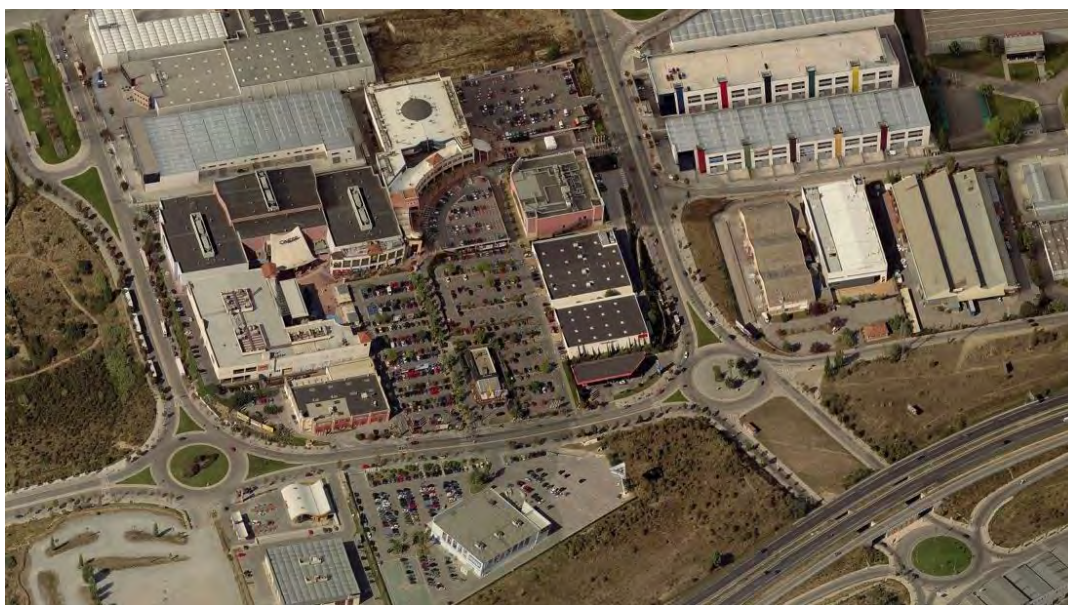
II-lustració 1-1 Zona Comercial i d'Oci Parc Vallès, construïda sobre sòl que en principi era de finalitat industrial amb una superfície de 82.000 m 2 . Font: Big Maps
