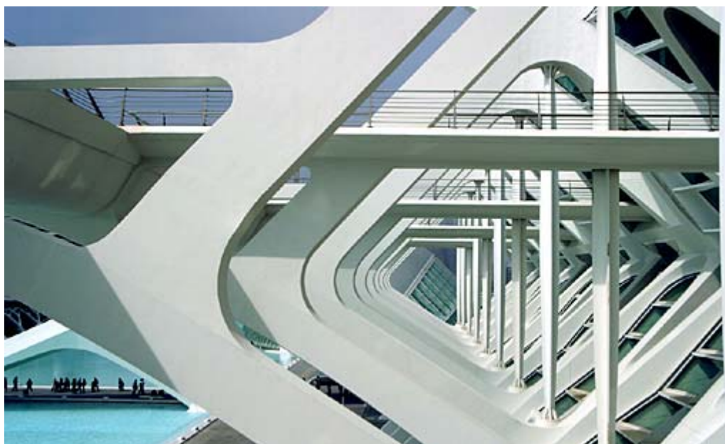
Imatge 103. Detall de l'estructura del Museu de les Ciències
