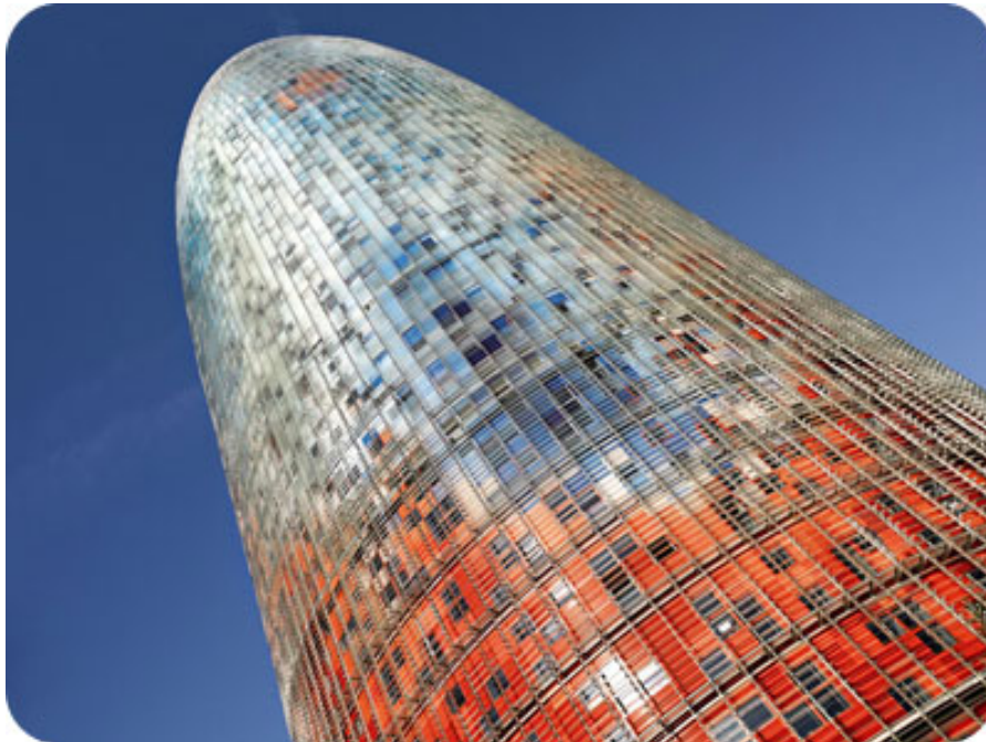
Imatge 130. Estructura de la Torre Agbar
