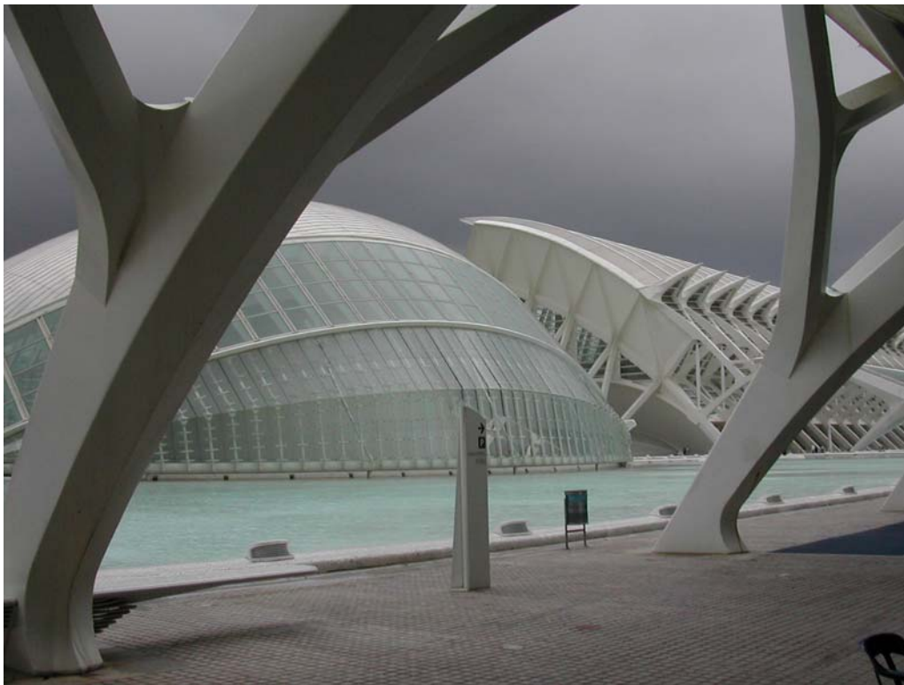
Imatge 106. Conjunt de la Ciutat de les Arts. Marca arquitectònica de València.
