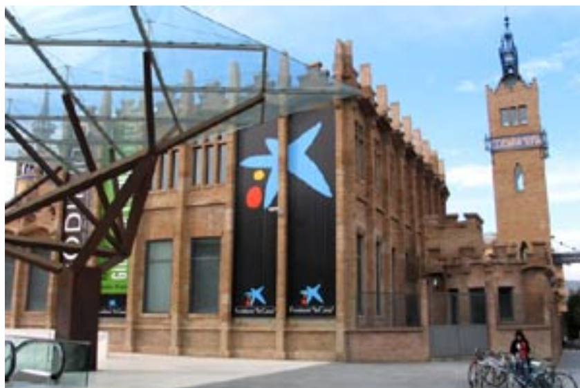
Imatge 66. Fàbrica tèxtil Casarramona. Actual Centre d'art: Caixaforum. Barcelona
