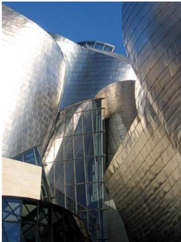
Imatge 84. Detall de les planxes de titani
