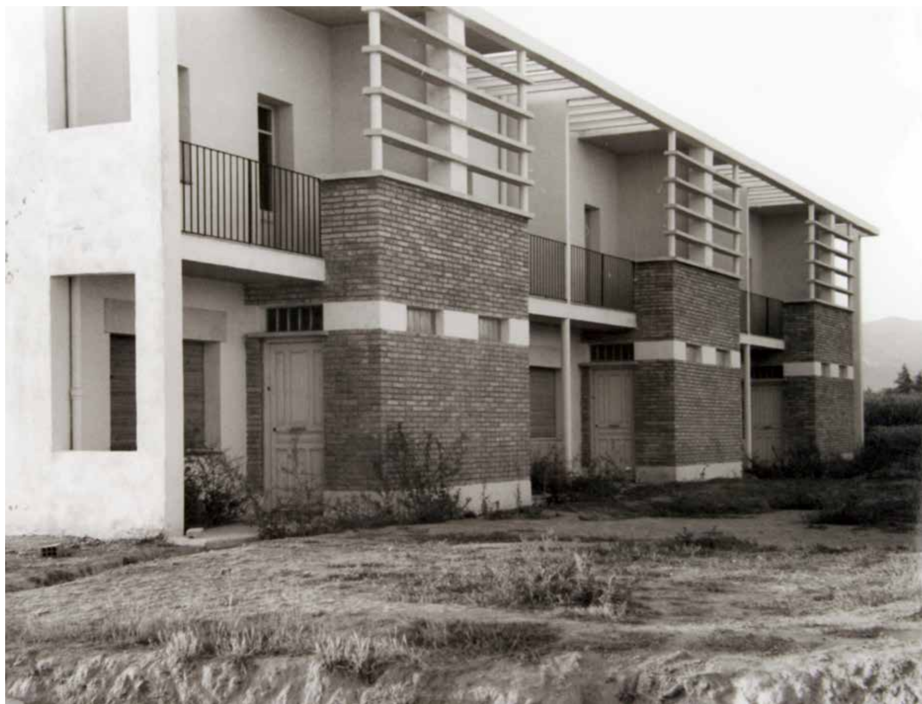
26 Façana dels habitatges del grup Sant Domènec, en un entorn perifèric
