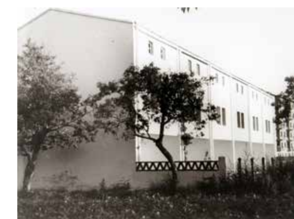
33 Les façanes testimonien els dos llenguatges i sistemes constructius de l'obra
