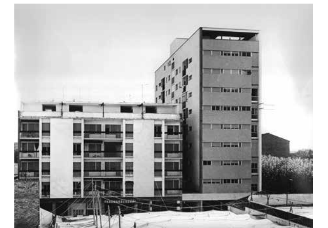
52 Edifici Almatà i edifici Sant Lluís
