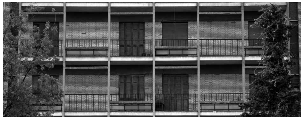
33 Imatge actual de la façana de l'edifici amb la gelosia de formigó a primer terme
