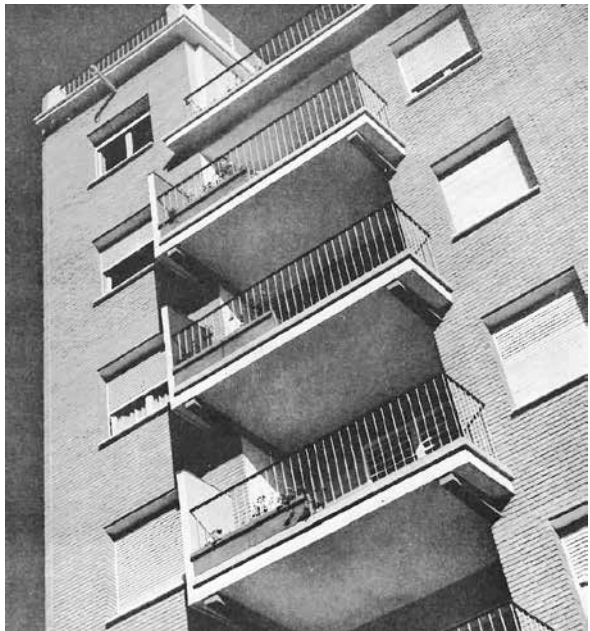
34 Façana de l'edifici al carrer Balmes, 39 de Barcelona. FJ Barba Corsini, 1955
