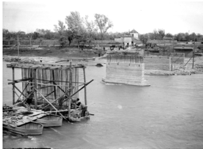
7 La construcció del pont nou
