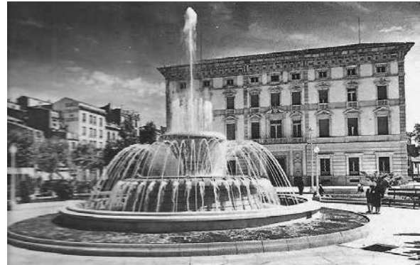
39 Govern Civil a Lleida. Reconstrucció de LI Domènech (1955)
