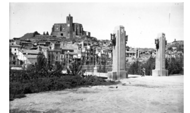
11 Pont nou des del marge esquerre, primers anys 40
