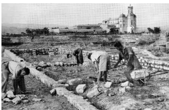
19 Moment de l'execució dels fonaments amb pedres de l'entorn, en la construcció de les cases del grup
