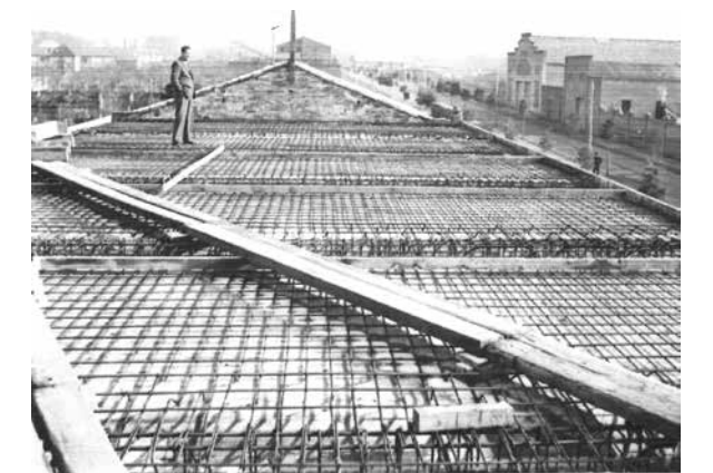
47 L'estructura en construcció. Al fons un passeig encara dessolat que contrasta amb la proposta de l'obra
