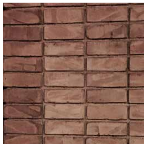
13 Mur amb junta de retícula. Mur que flexiona Cases del carrer Cadí
