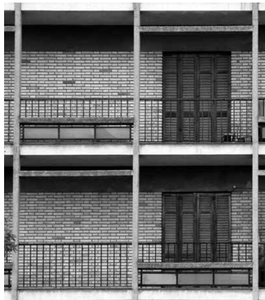
37 Imatge actual de la façana de l'edifici Pare Sanahuja
