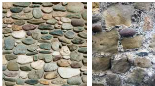
6 Còdols del mur de l'edifici Pijuan 7 Còdols a la muralla de Balaguer. S. XIV
