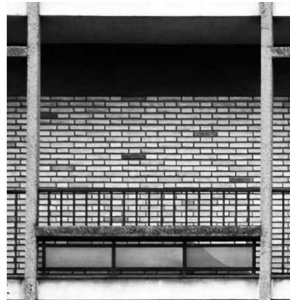
17 Imatge actual de la barana de l'edifici Pare Sanahuja. Combinació de rodons metàl·lics i vidre imprès
