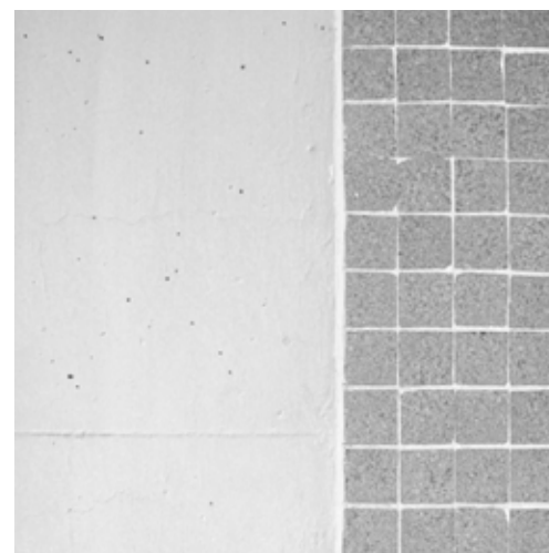
15 Formigó llis i plaqueta de gres vitrificada Edifici Almatà
