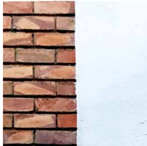
10 Mur ceràmic a trencajunts i mur arrebossat. Cases del carrer Cadí
