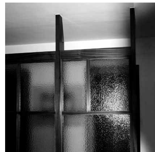
9 Imatge actual de la mampara de fusta i vidre entre l'espai de circulació i el menjador a l'edifici Almatà
