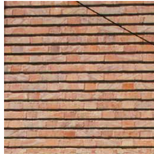
12 Mur amb junta horitzontal Edifici Campàs Delsams
