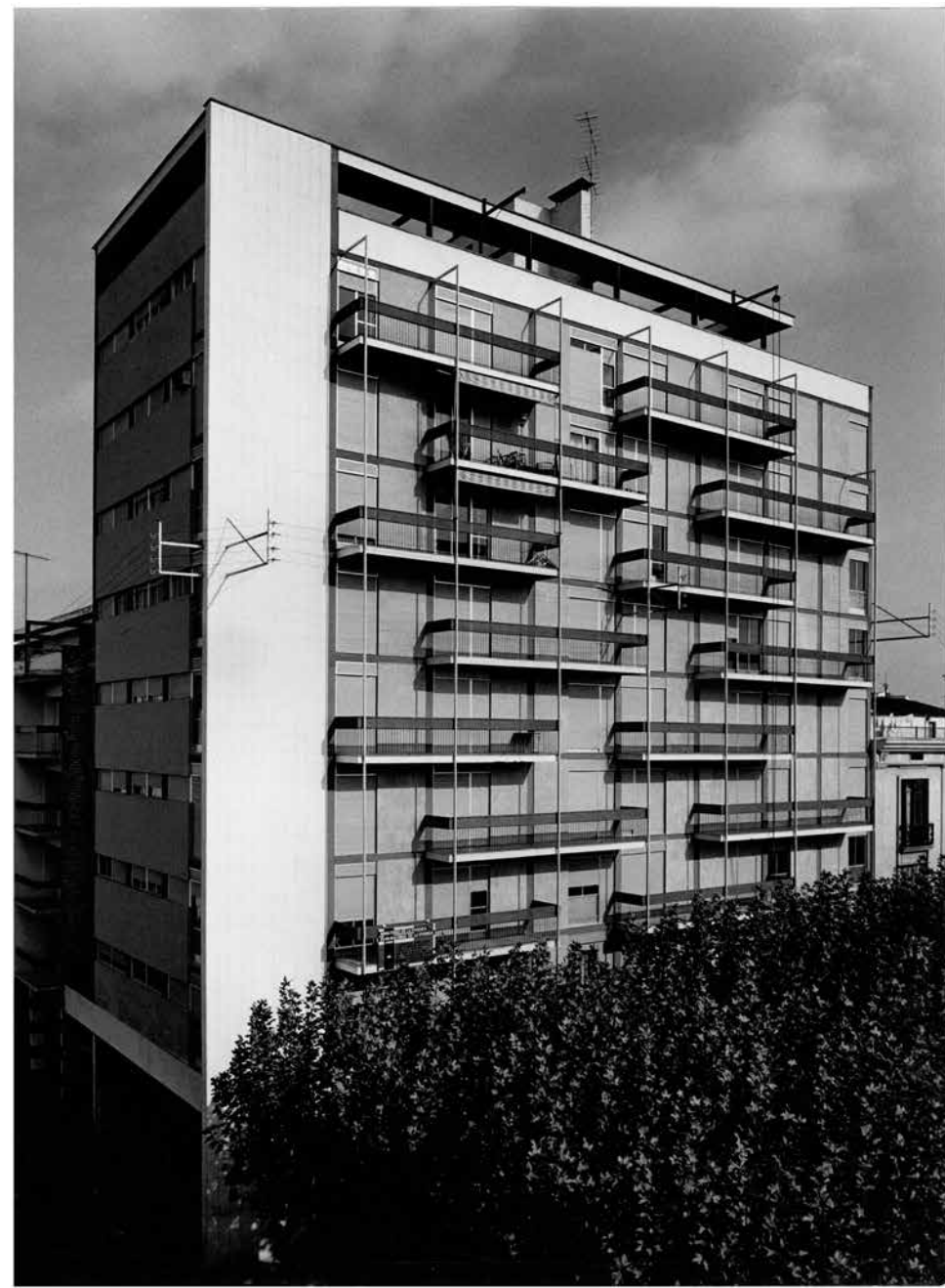
38 Imatge de l'edifici Almatà que mostra la seva corporeïtat i la configuració de la façana principal
