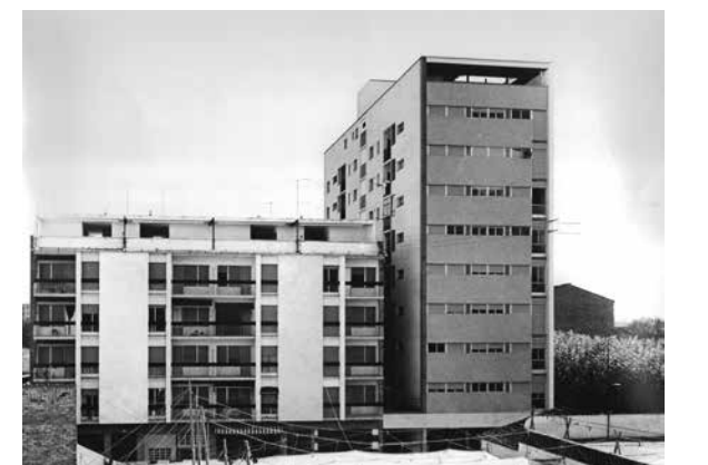
49 Façana principal de l'edifici Sant Lluís i testera de l'edifici Almatà
