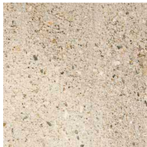
14 Formigó abuxardat d'àrid fluvial Edifici Pijuan
