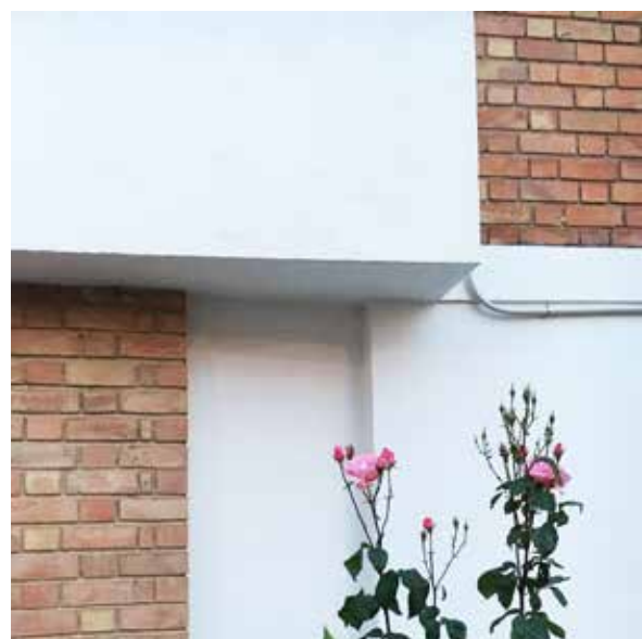
26 Imatge actual de la composició en escaquer del mur d'obra ceràmica i del mur blanc arrebossat
