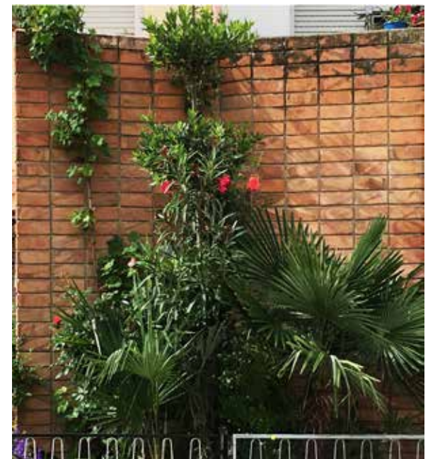
28 Imatge actual de la vegetació sobre el mur flexionat d'accés a la casa en filera del carrer Cadí
