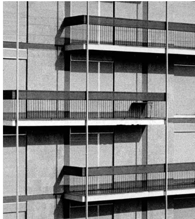
29 Façana de l'edifici Almatà. Paleta de colors grisos i enrasament de les superfícies
