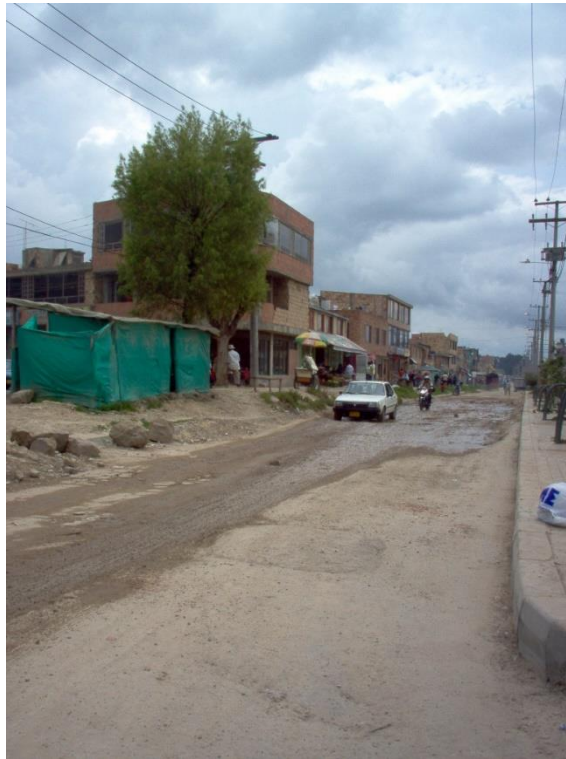
Figura 2 Vía urbana en mal estado en una zona periférica de la ciudad de Bogotá, Colombia
