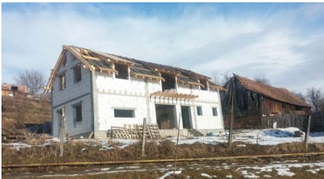
Foto 17. Casă în construcție a unor migrați din Spania (Alțâna) Construcție realizată din BCA
