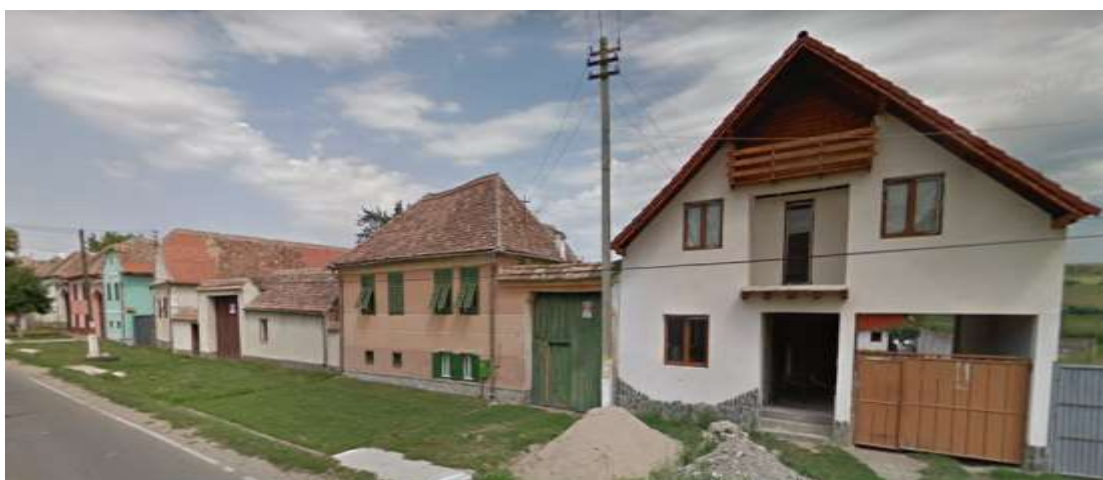
Foto 18. Casă renovată, neadaptată cerințelor zonei (Alțâna) Acoperiș în două ape cu intrarea din strada principală, izolație de polistiren, geamuri termopan și balcon, total nepotrivită locului (strada principală din Alțâna).
