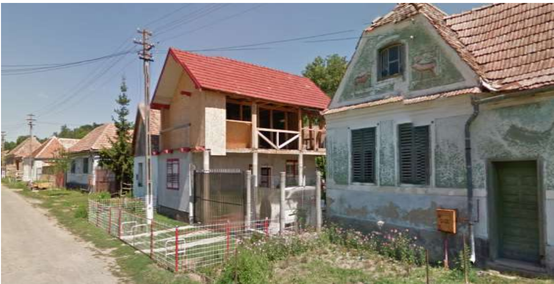
Foto 20. Mansardare făcută "după ureche" (Ghijasa de Sus) Mansardă realizată din OSB, material neadaptat condițiilor climaterice ale zonei.
