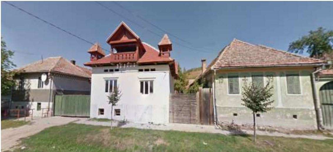
Foto 19. Casă nou construită, neadaptată cerințelor zonei (Benești) Turnulețe, balcon de lemn în fațada principală și geamuri cu 3 canate.
