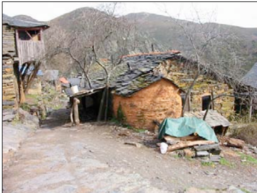
Foto 2. Calle principal de El Roble.
