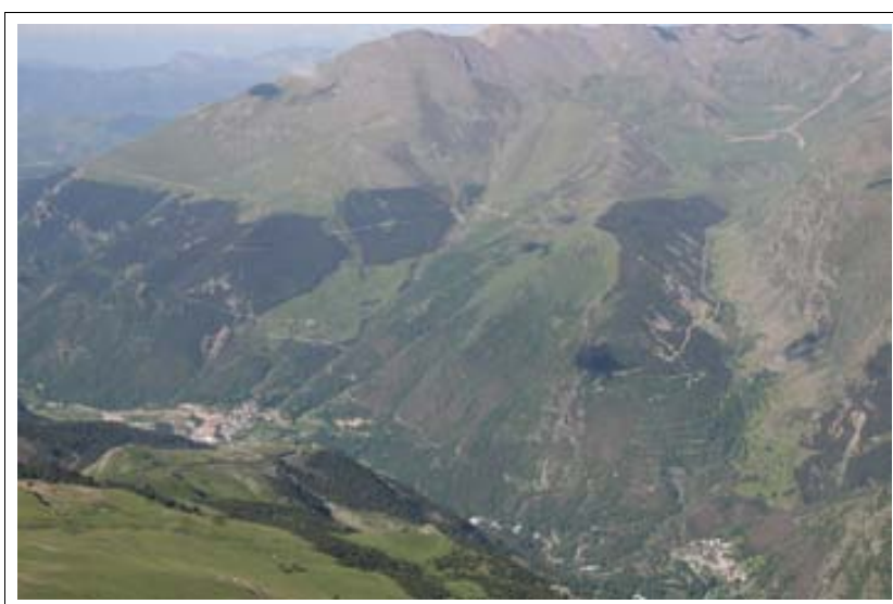
Figura 15: Poble d'Espui (esquerra, al fons de vall) i muntanya de Filià (part superior dreta) fotografiats des del Serrat de la Mainera. Situació de les obres a les futures pistes d'esquí, juny de 2007
