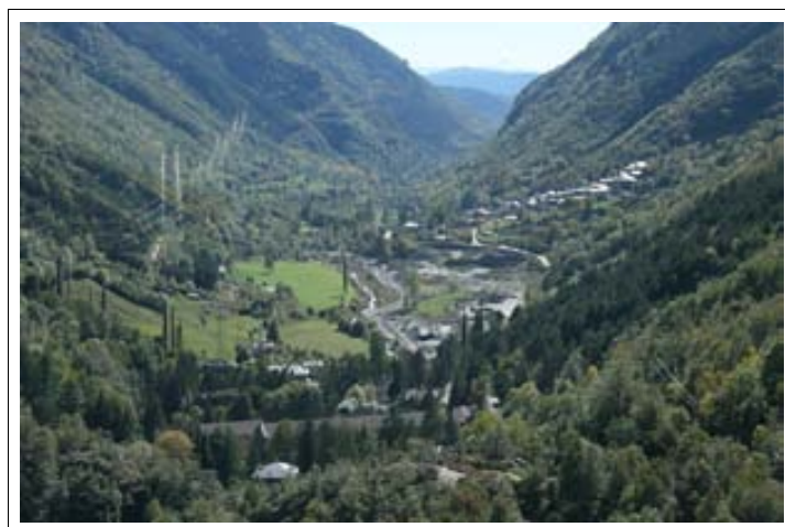
Figura 16: Espui (des de Cabdella). Obres al fons de vall. Octubre de 2007
