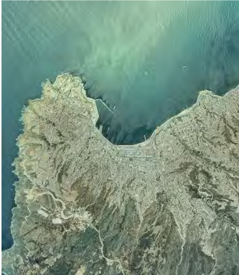
Fig. 3.21 Valparaíso, hoy. Se aprecia como la ciudad ha ido cubriendo la bahía, transformando la superficie natural en superficie mineral. Fuente: Google Earth.
