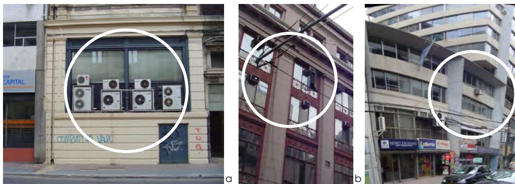
Fig. 4.3.47 (a, b, c) Imágenes de fachadas de la zona 2 A indicando elementos de aire acondicionado. Fuente: C. Carrasco, 2008.
