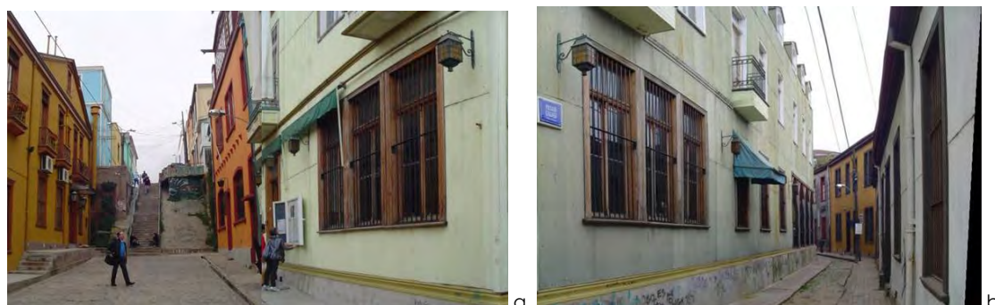
Fig. 5.8 (a, b) Pasajes estrechos en ladera, C' Concepción, entorno de la zona 2 B. Fuente: C. Carrasco.
