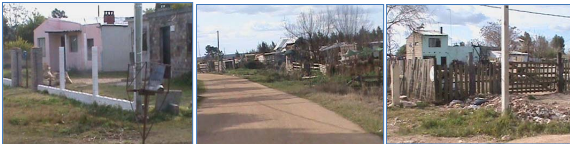
IMAGEN 3. Calles y casas de la localidad de Pinar Norte.
