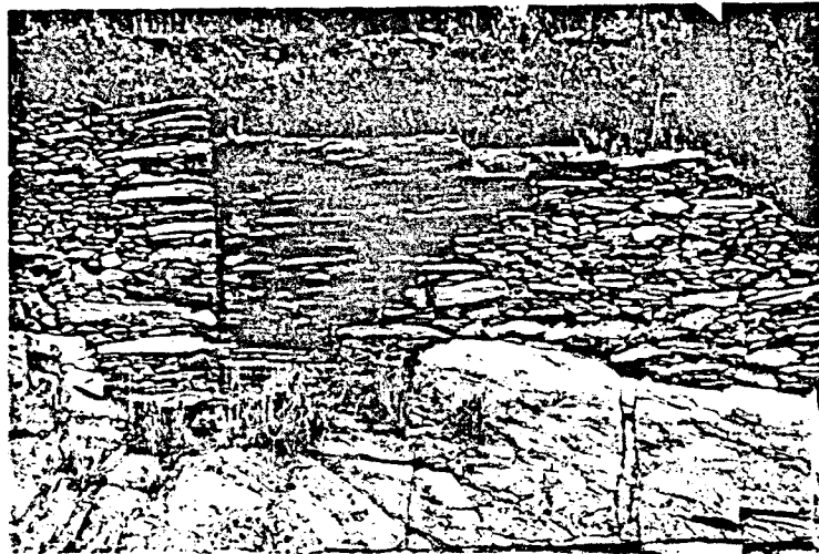
En bancales que deben salvar una altura de una cierta envergadura, las escaleras se colocan longitudinalmente al muro.
