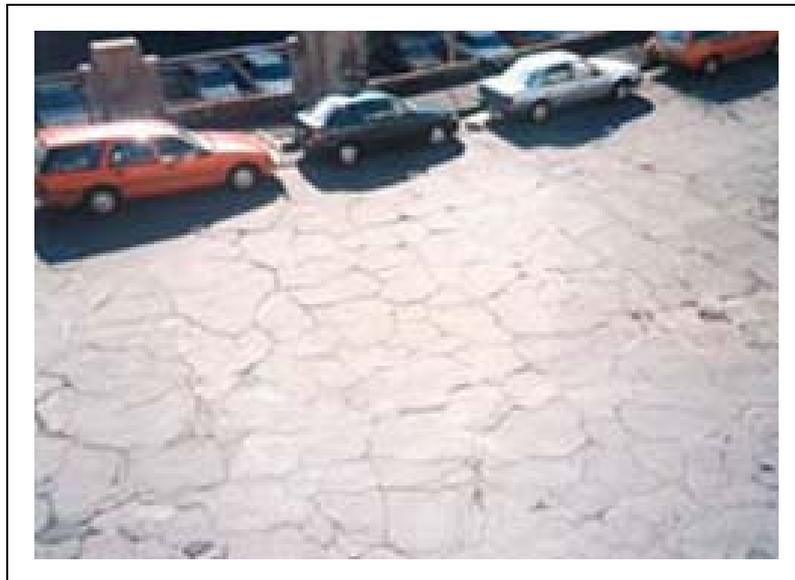
**Fig. 2.3.2** Fisuración en bloque (*Fuente: Aircraft pavement maintenance manual, 1997*)
