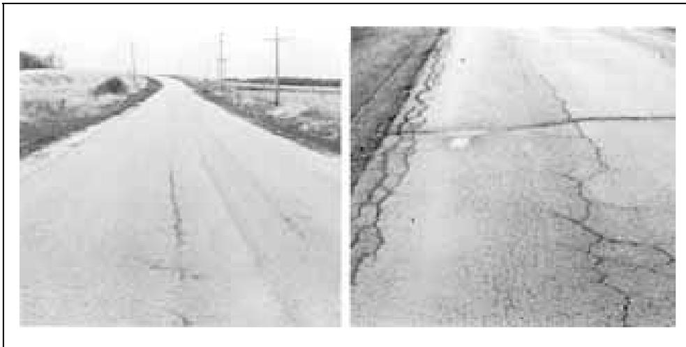
**Fig. 2.3.3** Fisuras longitudinales (Fuente: Hardin Paving Company <[www.hardinpaving.com](http://www.hardinpaving.com)>)
