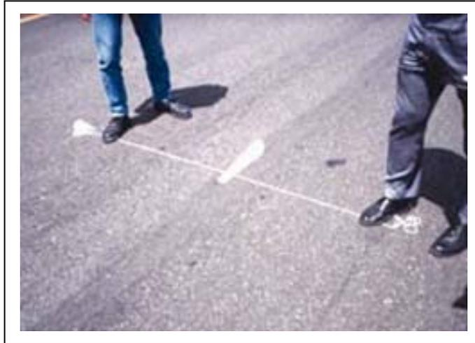
**Fig. 2.3.5** Hundimiento de la superficie de un firme bituminoso (Fuente: *Aircraft pavement maintenance manual*, 1997)
