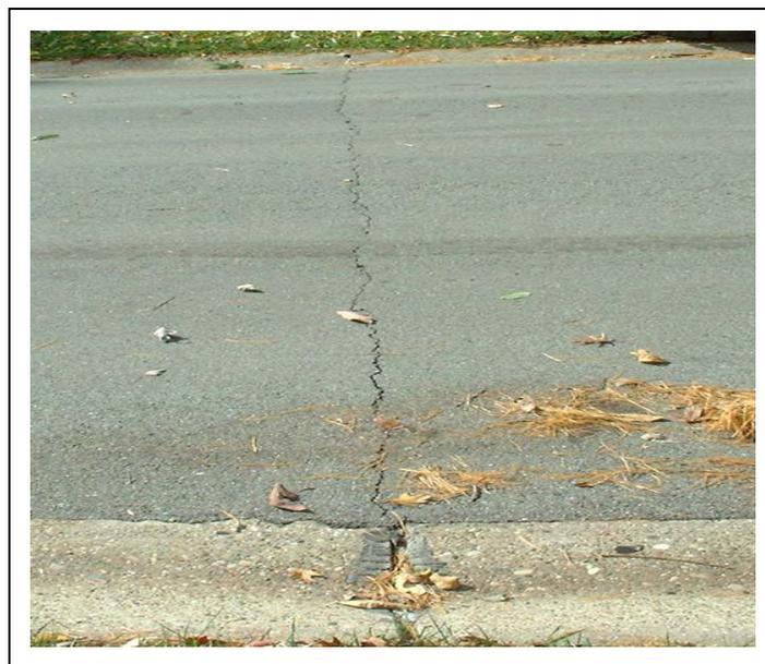
**Fig. 2.3.4** Fisuras transversales en un pavimento asfáltico (Fuente: Flynn Brothers <flynnbrothers.com>)
