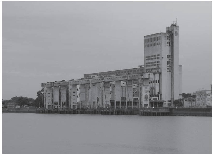
3.47. Vista del silo, año 2008. Fuente: Fotografía tomada por Javier Fedele.
