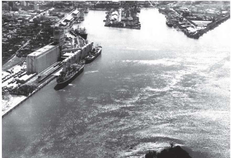
3.43. Vista del Puerto de Santa Fe, con el silo elevador de granos en primer plano. Año 1962. Fuente: Archivo Ente Administrador Puerto de Santa Fe.
