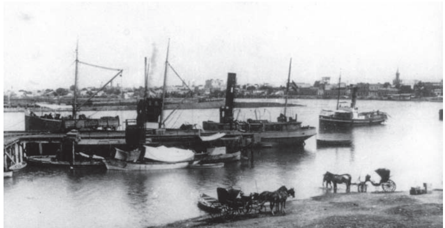
3.6. Vista del Muelle del Ferrocarril Santa Fe. Sin fecha. Se observa la precariedad de las instalaciones. Fuente: Archivo General de la Provincia de Santa Fe.
