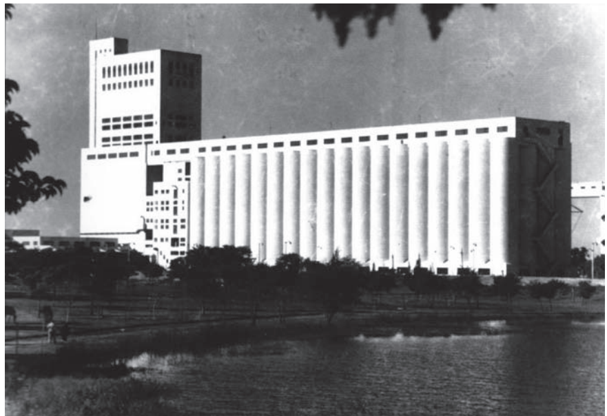
3.46. Vista del silo elevador de granos que se constituyó en el signo edilicio más fuerte del puerto. Año 1962. Fuente: Archivo Ente Administrador Puerto de Santa Fe.
