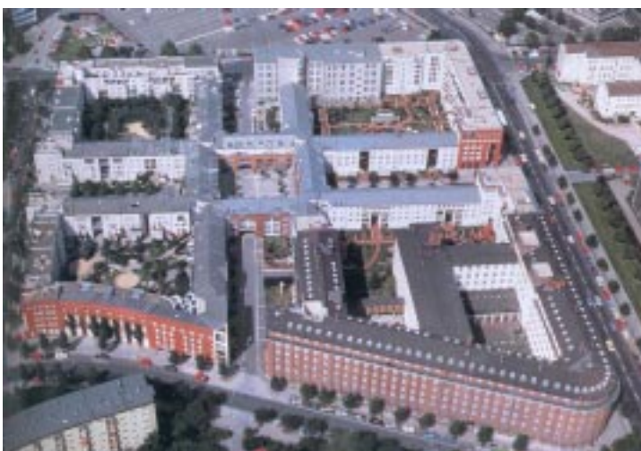
Vista aérea do conjunto
