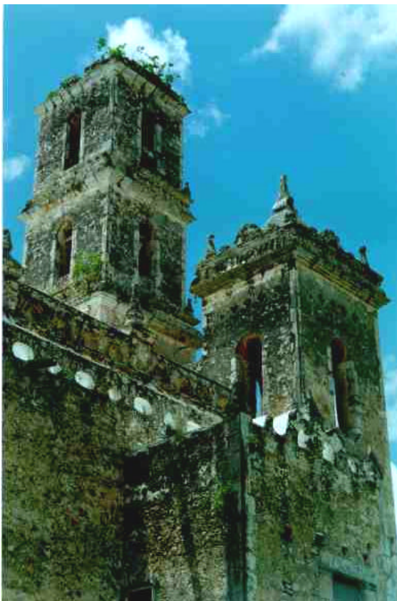
Figura 8. Vegetación sobre muros y torres producto de la humedad. Iglesia parroquial de Yaxcabá
