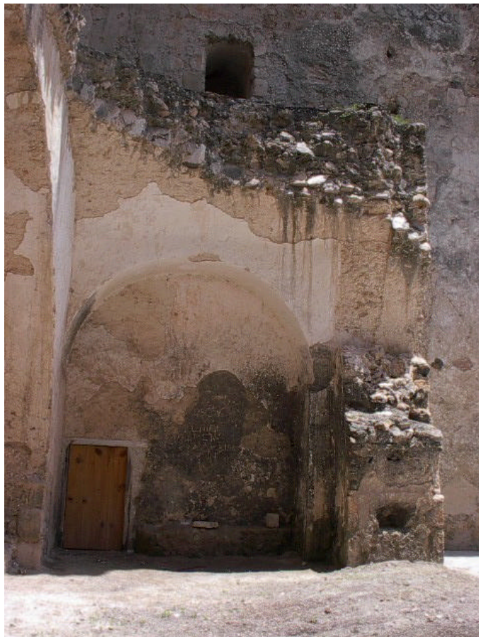
Figura 6. Humedad en muros. Iglesia del ex convento de Uayma, Yucatán.
