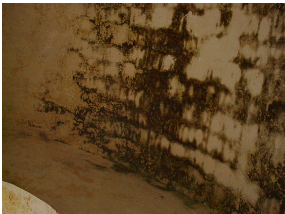
Figura 12. Humedades por falta de mantenimiento en la cubierta de la nave de la iglesia del ex convento de Teabo.
