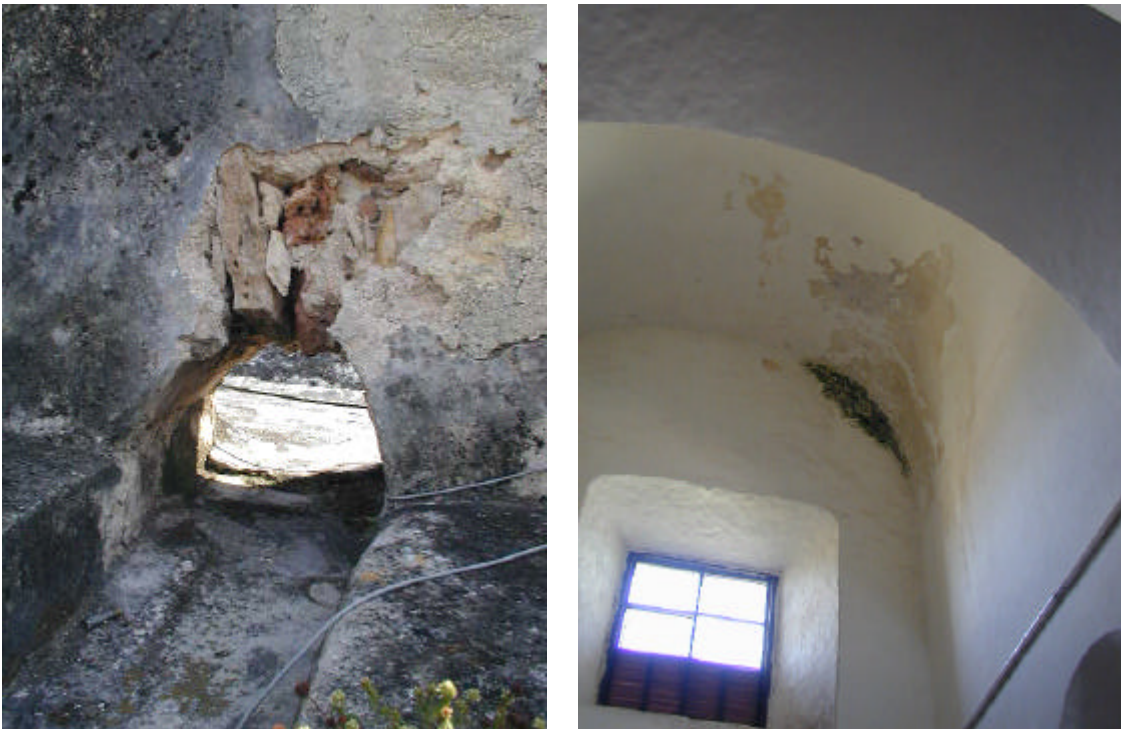
Figura 13. Humedad por filtración producida por canal de desagüe en mal estado. Iglesia del ex convento de Conkal.
