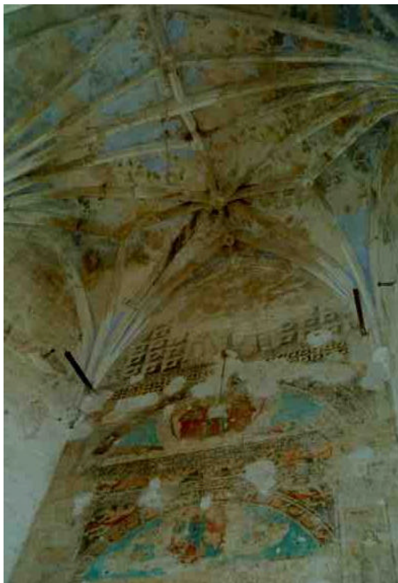
Figura 11. Humedades causadas por grietas y falta de mantenimiento. Filtraciones en la bóveda del presbiterio de la iglesia de Dzidzantún, Yucatán
