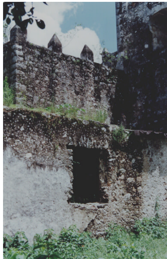
Figura 9. Disgregación de morteros y erosión de la piedra. Tixcacalcupul, Yucatán.
