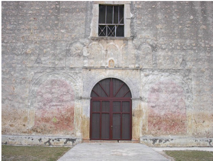
Figura 7. Humedad ascendente en Muros. Iglesia del ex convento de Temax.
