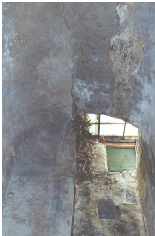
Figura 10. Humedades causadas por grietas y desplomes en la cubierta. Ex convento de Dzidzantún, Yucatán
