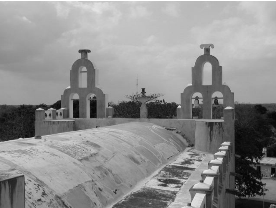
Vista superior de la bóveda de la nave de la iglesia de Tabi.
