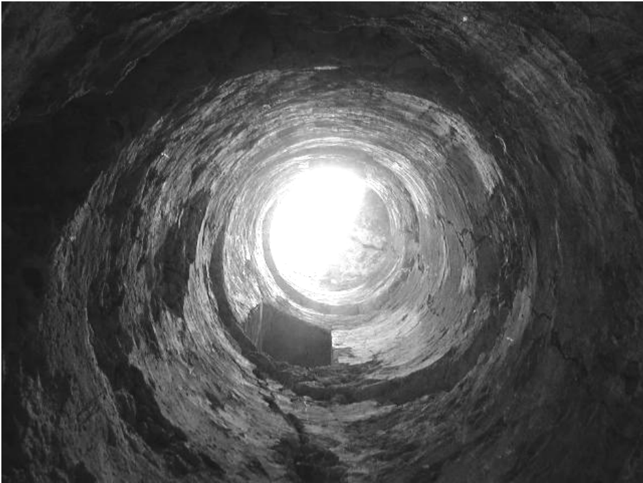
Caja de escalera de caracol. Iglesia de Kikil
