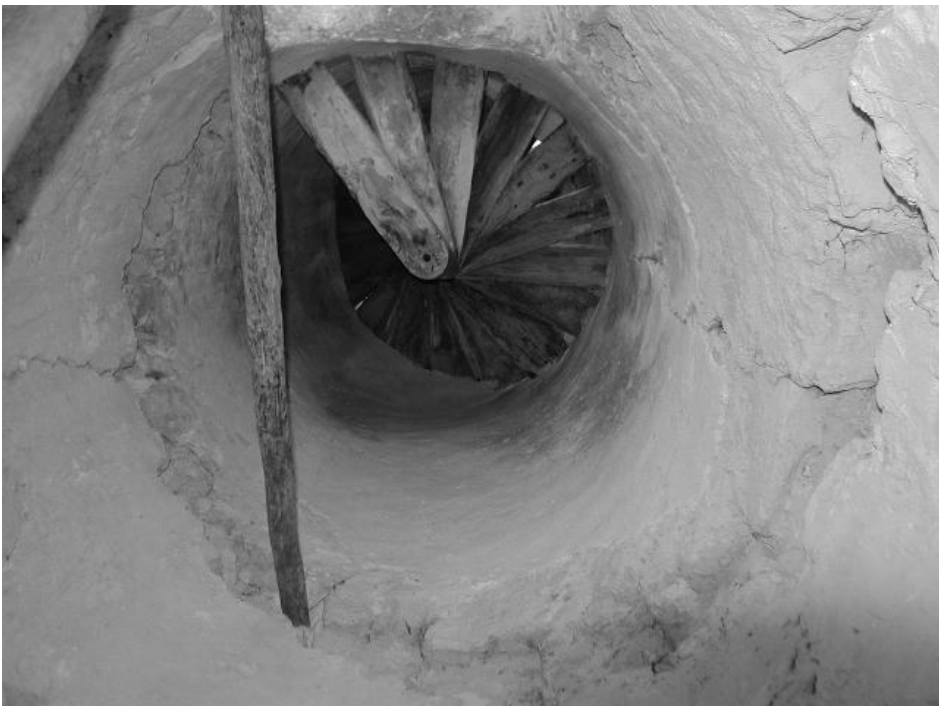
Caja de escalera de caracol, de madera. Iglesia de Yaxkabá
