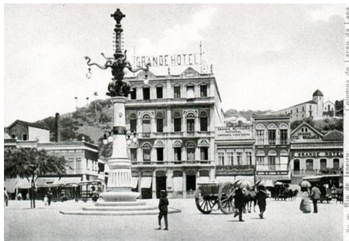
Fig.19 Lampadario del Largo da Lapa, construido en 1909. Brazos de bronce en forma de serpiente, sustentan luminarias de arco voltaico. Fuente: http://www.fotolog.net/rioantigo/
