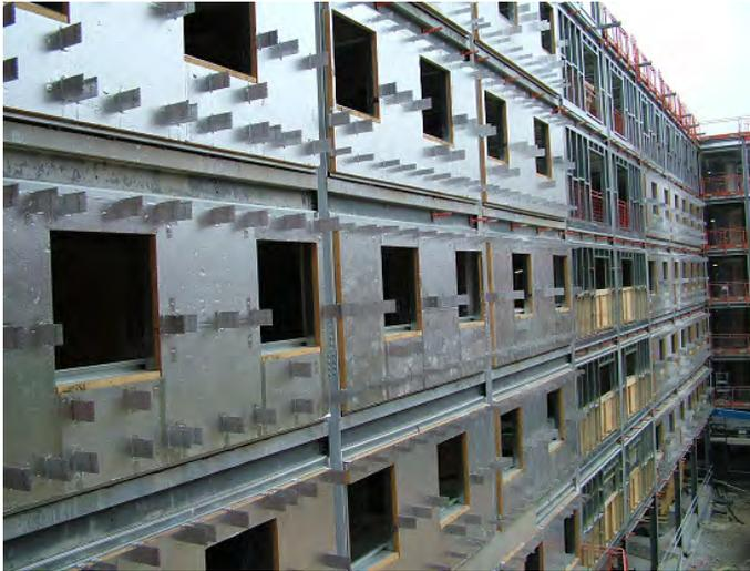
*Hoja interior formada por un entramado de acero plementado con un panel aislante por la cara exterior. A este entramado se fijan cartelas de anclaje para la hoja exterior que atraviesan el panel aislante. El conjunto llega montado a obra de manera que sólo falta colocar el trasdosado interior y la hoja exterior.*
