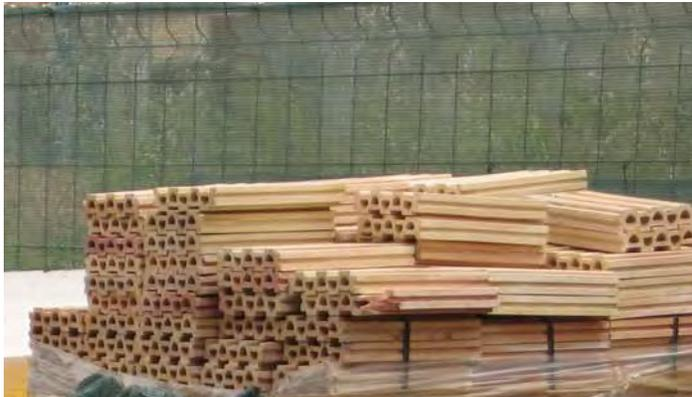
“Cobert del Batre”. Una única pieza cerámica sirve para construir arcos, pilares, viguetas y cubierta. Rehabilitación Arq. Clotet y Paricio.
