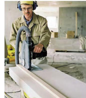
Corte en obra de las placas de hormigón aireado.
