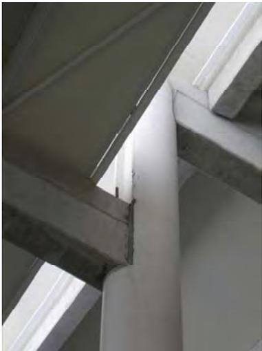
Encuentro inequívoco entre un pilar y una jácena de hormigón prefabricado.
