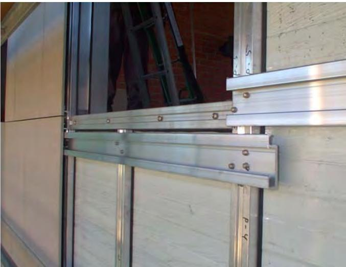
La hoja interior la forman los paneles sándwich habituales del sistema. Se fijan a los montantes por medio de presores que los retienen como si fueran los vidrios de un muro cortina. Burletes de material polimérico conformado garantizan la estanqueidad de la unión entre el perfil y el panel.
