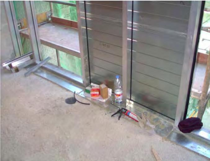
La hoja exterior fija su subestructura directamente atornillada sobre el montante de la interior. El trasdosado, anclado a los mismos montantes, debe garantizar la resistencia al fuego y mejorar la atenuación acústica.
