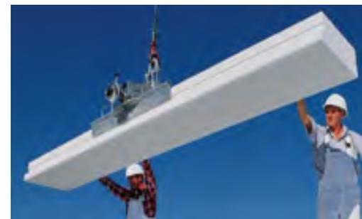
Hebel (Xella). Losa de cubierta CC 3/500.
