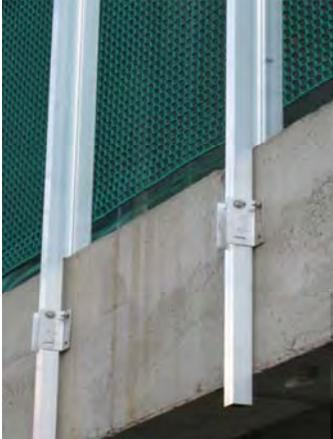
igual que la posibilidad de retener al vuelco con la misma fijación que soporta el panel vecino en posición superior o inferior.
