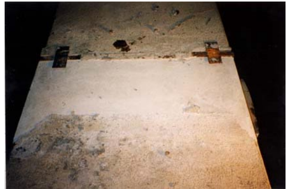
Fotografía 4.20 Zona de apoyo central reparada con microhormigón sin retracción
