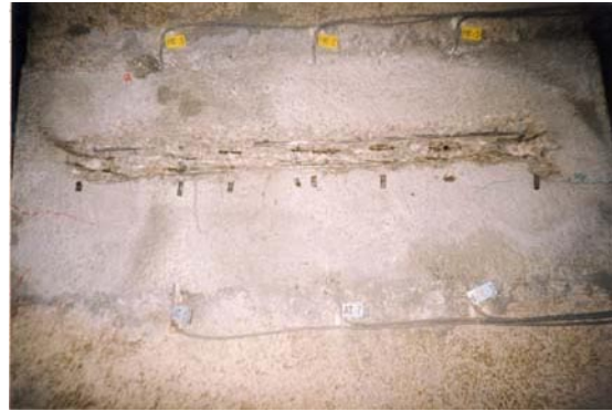
Fotografía 4.34 Preparación del hormigón y el acero en apoyo intermedio.
