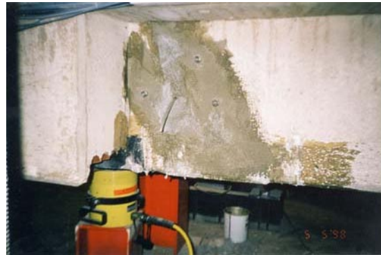
Fotografía 4.54 Sellado e inyección de las fisuras.
