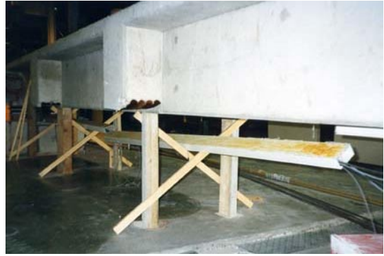
Fotografía 4.18 Trabajos preliminares de apeo provisional
