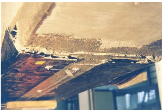
Fotografía 4.46 Vista de la sección de desviador después del ensayo.
