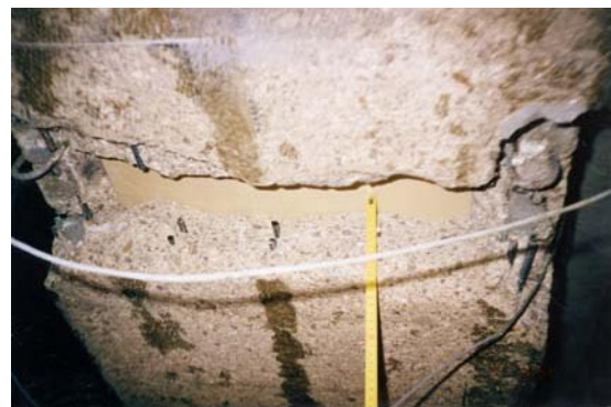
Fotografía 4.52 Vista de los trabajos cercanos al desviador nº 4.
