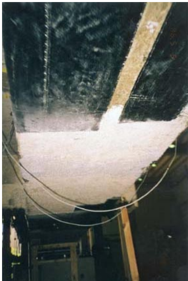
Fotografía 4.55 Encofrado y hormigonado de zonas dañadas.
