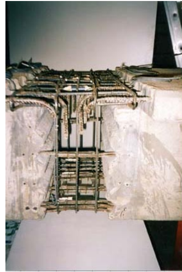
Fotografía 4.28 Vista de la colocación de las galgas embebidas en apoyo.
