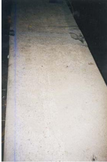
Fotografía 4.37 Preparación superficial del hormigón.
