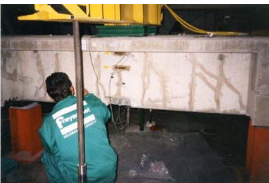
Fotografía 4.35 Preparación y sellado de fisuras en sección de centro luz vano 1.
