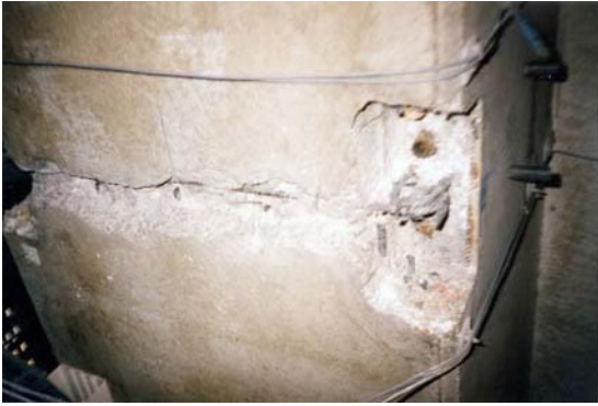
Fotografía 4.33 Preparación del hormigón y el acero pasivo en centro luz vano 1.
