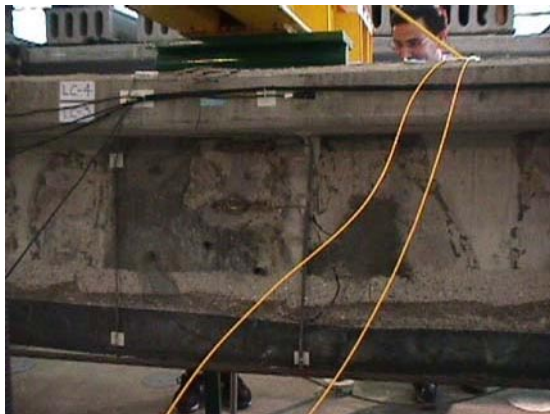
Fotografía 4.58 Vista de la sección de apoyo central con la fibra óptica colocada (cables amarillos)
