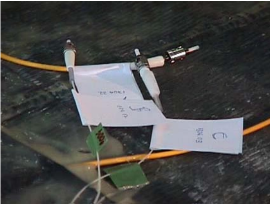
Fotografía 4.62 Vista de la sección de apoyo central con la fibra óptica colocada.
