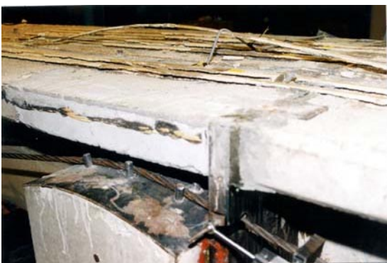
Fotografía 4.25 Vista del apoyo central, puede verse el control de las fisuras
