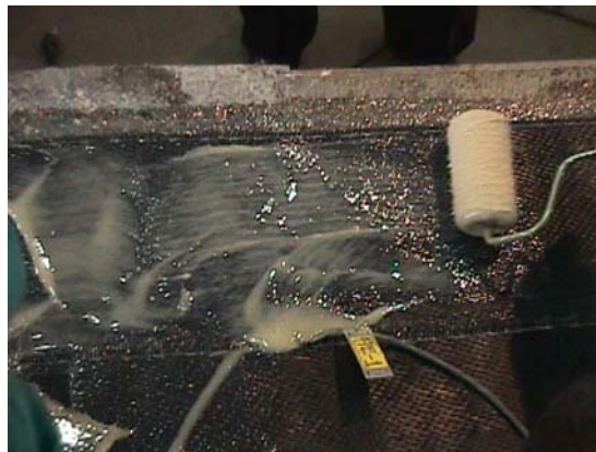
Fotografía 4.38 Vista de la colocación de la fibra de carbono en el apoyo intermedio.
