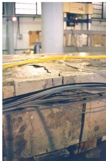
Fotografía 4.41 Vista del apoyo central después del ensayo.
