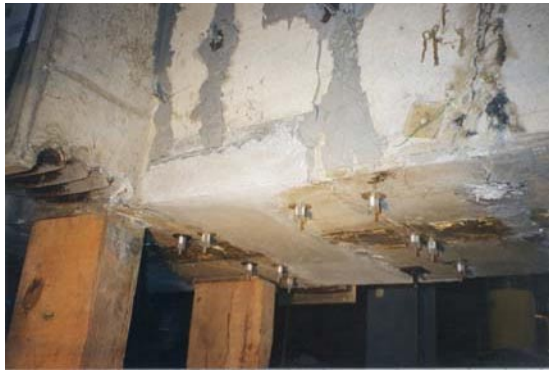
Fotografía 4.19 Vista de las zonas de hormigón reparadas y fisuras inyectadas
