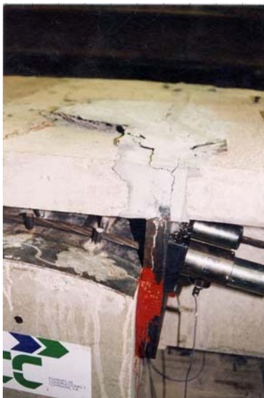
Fotografía 4.13 Aspecto de la sección de apoyo central.
