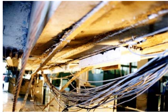
Fotografía 4.24 Vista inferior del vano cargado
