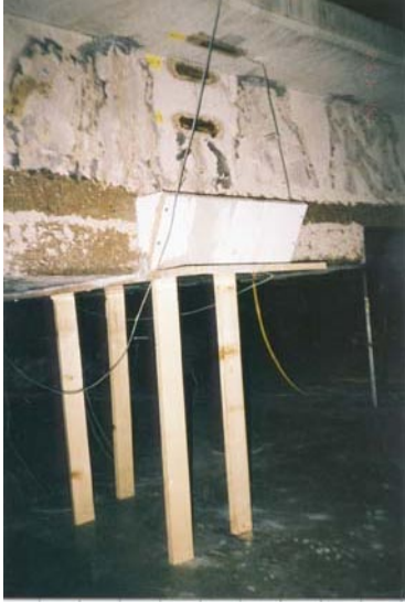
Fotografía 4.53 Encofrado y hormigonado de zonas dañadas.
