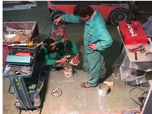
5.- Se da inicio a la colocación de las bandas distribuyendo la resina epoxi sobre la superficie de hormigón, utilizando para ello un rodillo con poco tejido; procurando dejar una capa abundante de resina. A razón de  $700 \text{ g/m}^2 \pm 50 \text{ g}$ . de material. El objetivo es llenar todas las imperfecciones del soporte y permitir una buena adherencia entre hormigón y el tejido de fibra de carbono.
