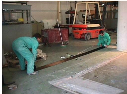
3.- En este momento se preparan las bandas de T.F.C. cortándolas con tijeras y teniendo el cuidado de pegar en la zona de corte una banda adhesiva para evitar que se deforme el final de la banda.
