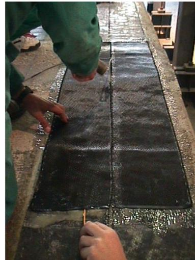
7.- Inmediatamente después de que está pegada la banda sobre la primera capa de resina epoxi, se procede a colocar una segunda capa de resina la cual se puede inicialmente aplicar con el mismo rodillo mencionado en el paso 5, en cantidades de  $700 \text{ g/m}^2 \pm 50 \text{ g}$ . de material; para seguidamente utilizar una espátula metálica para hacer que todo el tejido de fibra de carbono
